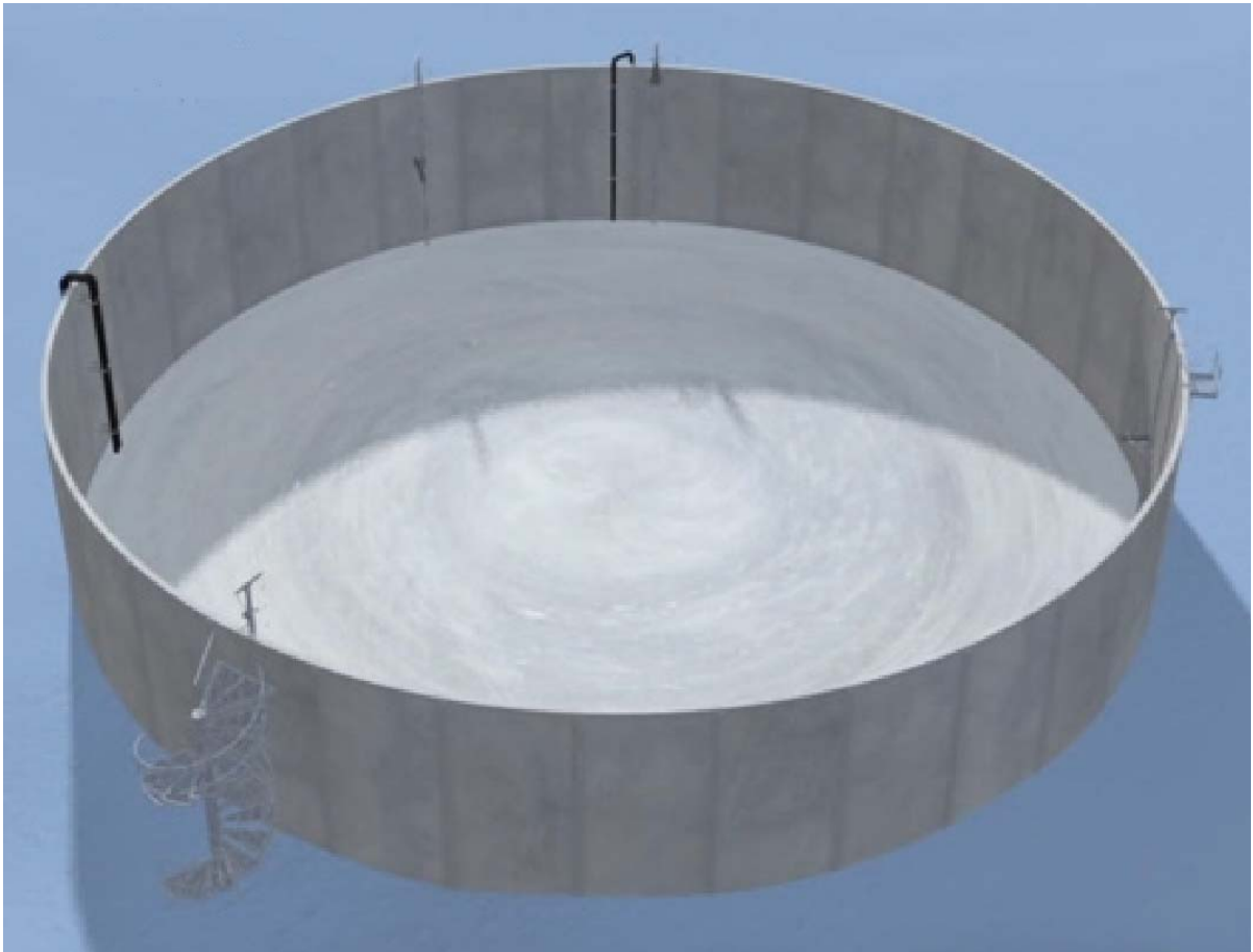
Σχήμα 3.12. Τσιμεντένια δεξαμενή αναερόβιου χωνευτήρα
