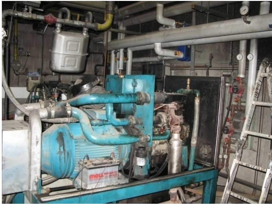
Σχήμα 4.1. Χειροποίητη μονάδα συμπαραγωγής
