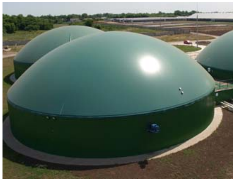
Σχήμα 3.14. Πανοραμική άποψη ενός βιοαντιδραστήρα με οροφή αποθήκευσης βιοαερίου
