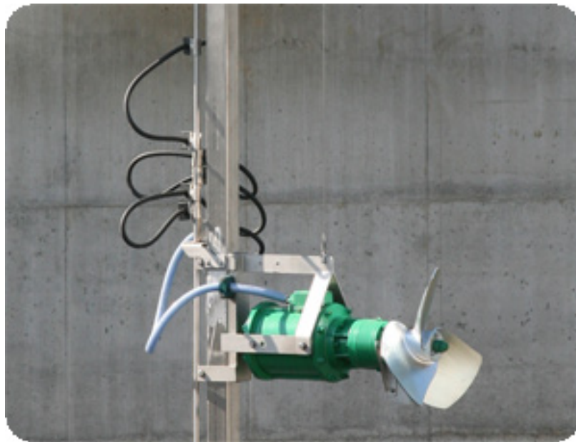
Σχήμα 3.18. Τυπική εγκατάσταση υποβρύχιου αναδευτήρα
