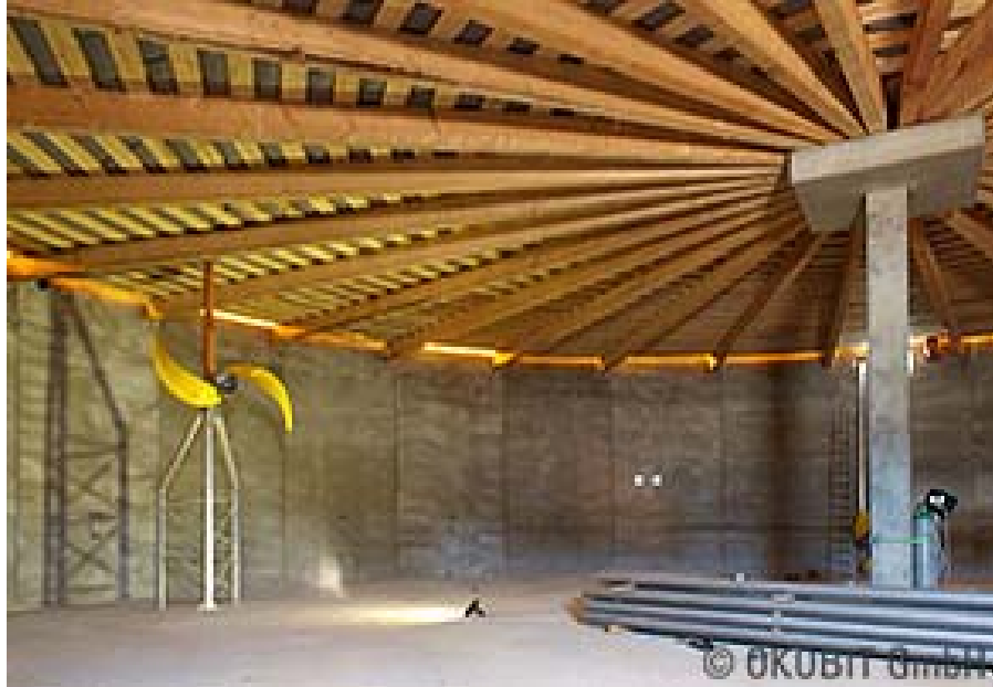
Σχήμα 3.13. Δείγμα ξύλινης οροφής βιοαντιδραστήρα
