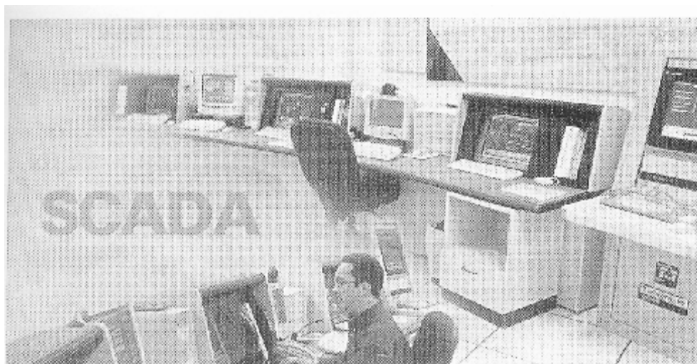
Εικ. 7: Χώρος κεντρικού συστήματος Τηλεμετρίας, Τηλεχειρισμού και Τηλεελέγχου.
