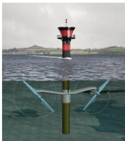
Σχήμα 1.7 - Διάταξη υποθαλάσσιας ηλεκτρογεννήτριας
