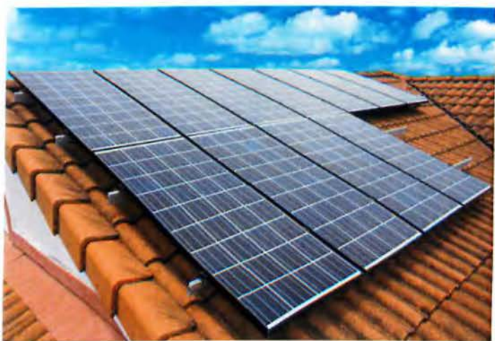
Σχήμα 2.3.3 Εγκατάσταση φωτοβολταϊκού πάνελ σε στέγη, [2.7]
