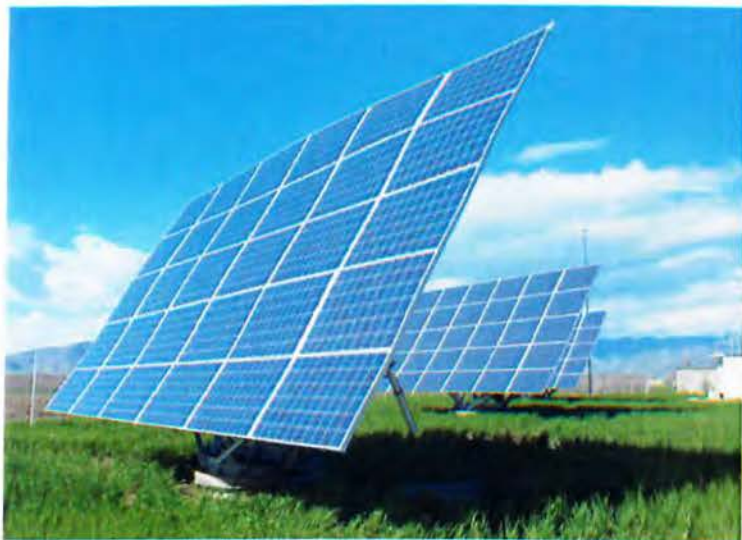
Σχήμα 2.3.4 Ηλιοστάτης εγκατεστημένος στο έδαφος, [2.8]
