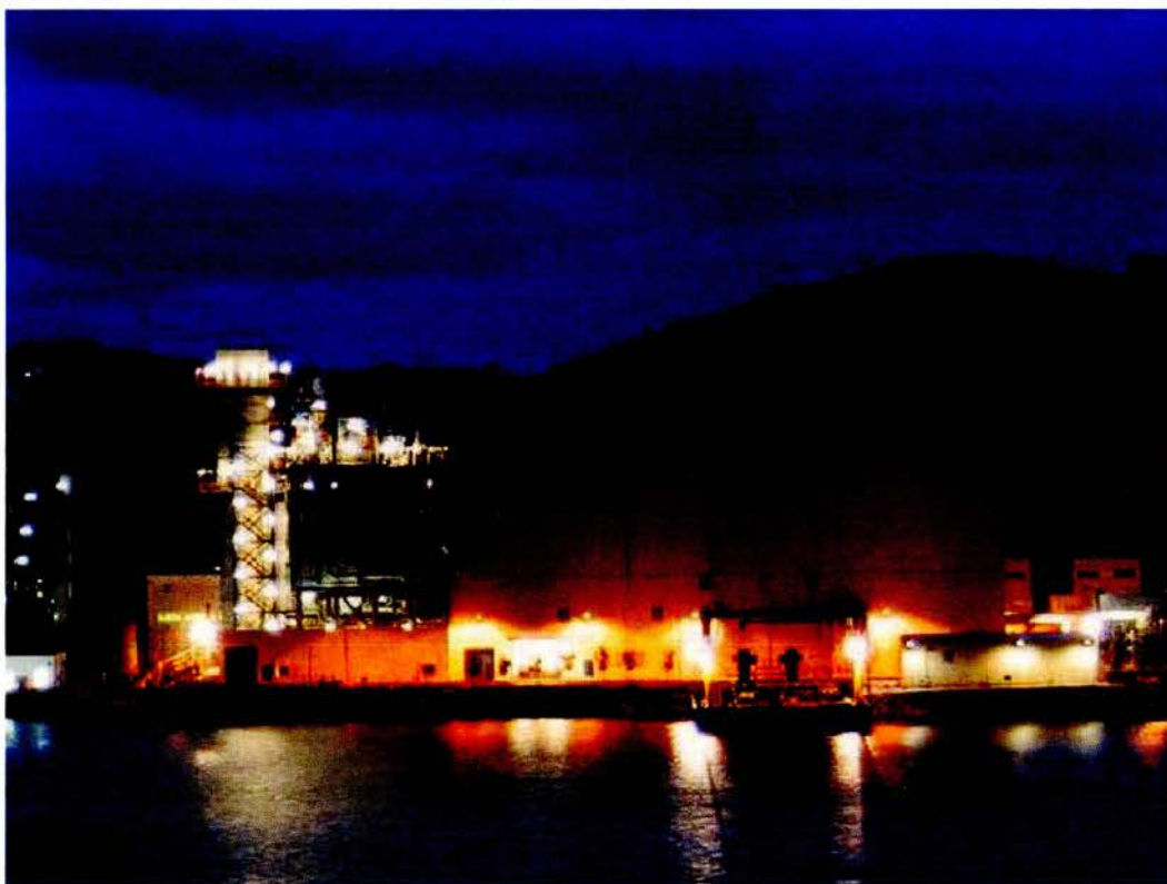
Σχήμα 5.2: Εξωτερική άποψη της μονάδας 5
