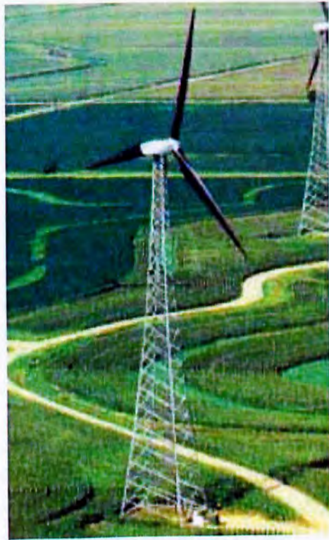
Εικόνα 19. Ανεμογεννήτριες με χαλύβδινους και δικτυωτούς πυλώνες αντίστοιχα
