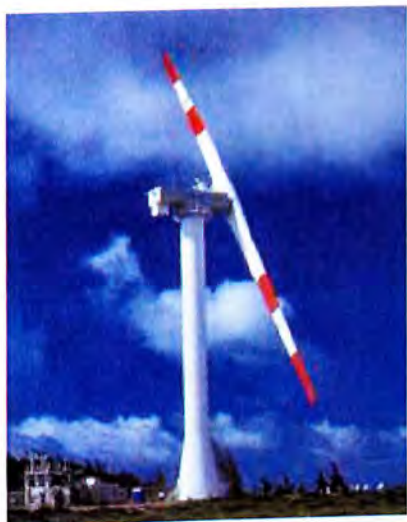
Εικόνα 17. Ανεμογεννήτριες δύο και τριών πτερυγίων
