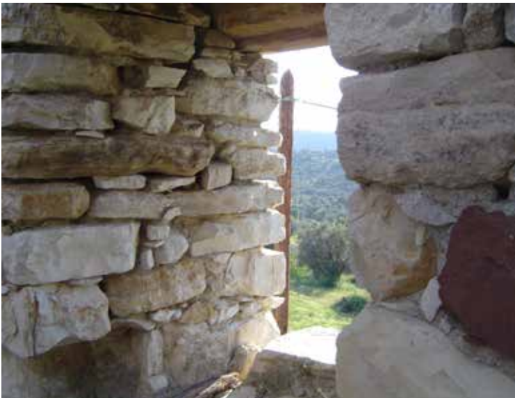
Χαρακτηριστικη λεπτομερεια του παραθυρου. Εμφανες το παχος της τοιχοποιιας
