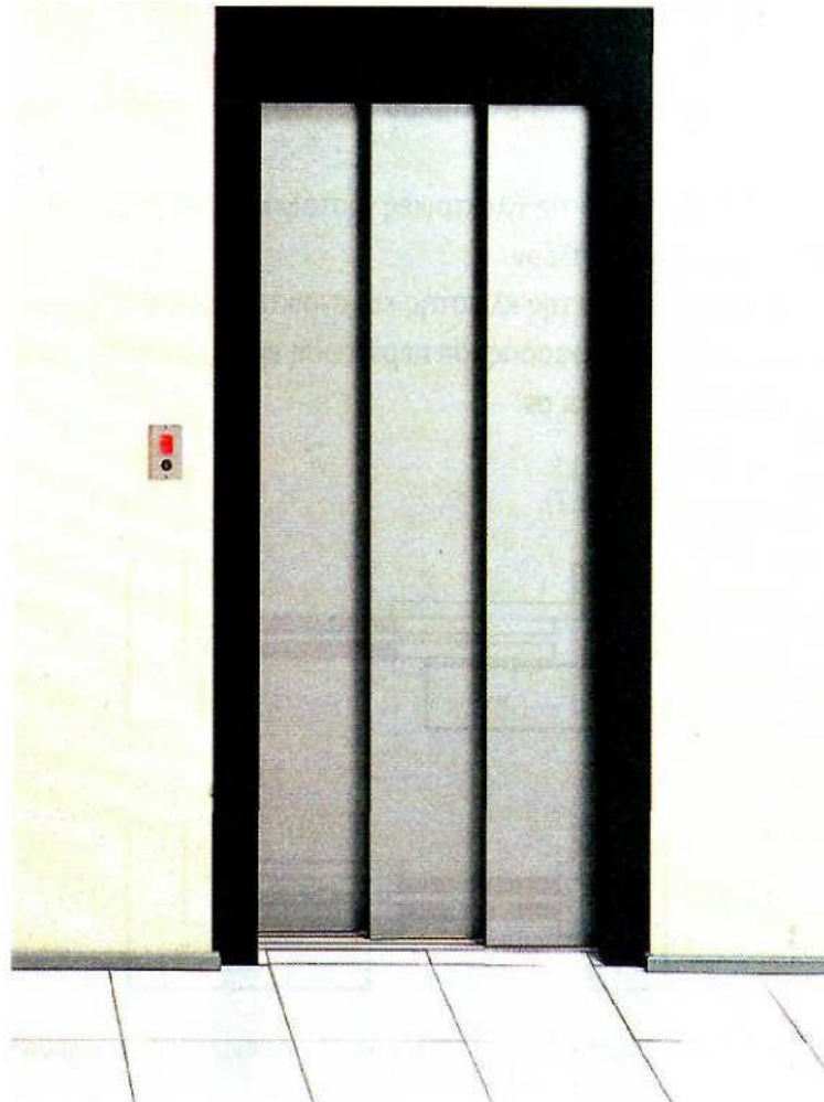
Σχέδιο 4.15β Τηλεσκοπική θύρα πλευρικού ανοίγματος
