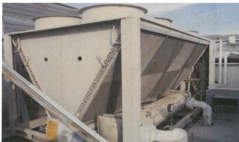
Εικόνα 3.4 Ψύκτης κλιματισμού
