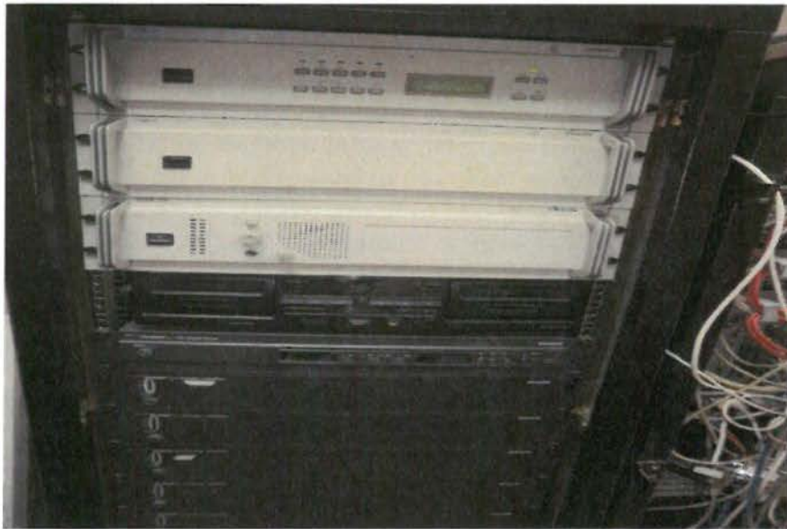
Εικόνα 3.14 Μεγαφωνική και Ραδιοφωνική Εγκατάσταση
