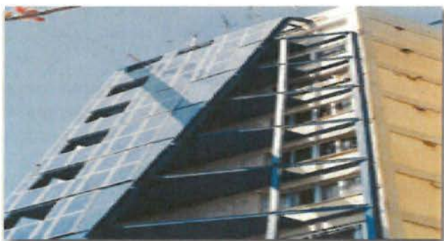
Εικόνα 1.3 Παρέμβαση στη κτιριακή δομή (παθητικά ηλιακά συστήματα)
