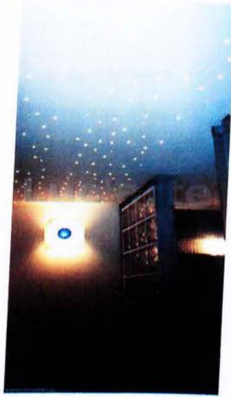
Εικ. 2.11 φωτισμός οροφής με οπτικές ίνες
