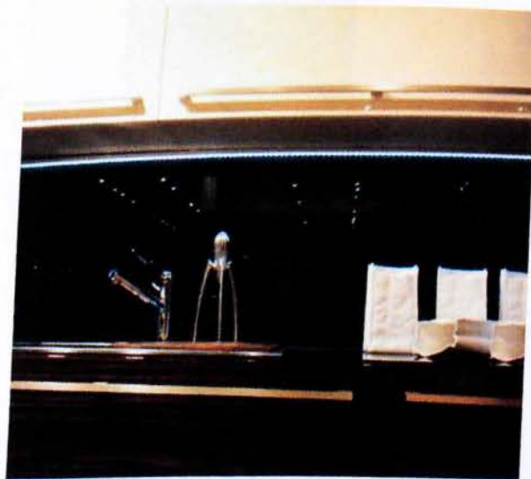
Εικ.2.14 Κρυφός φωτισμός ντουλαπιών με σωλήνα led
