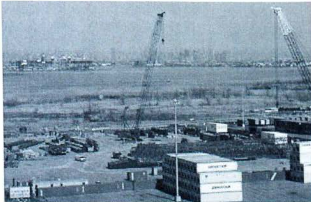
Εικόνα 5.18: Μεγάλοι γερανοί που διατάσσουν ογκώδη και βαριά φορτία σε υπαίθριο αποθηκευτικό χώρο.
