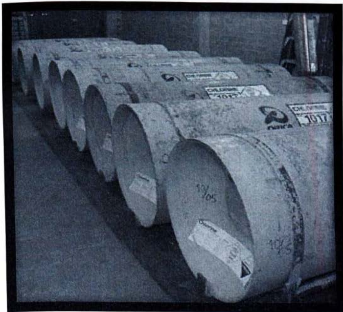
Σχήμα 8.1: ΧΩΡΟΣ ΑΠΟΘΗΚΕΥΣΗΣ ΦΙΑΛΩΝ ΧΛΩΡΙΟΥ
