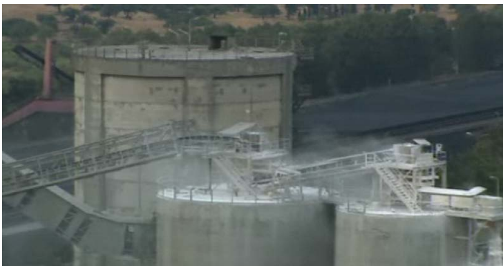
Εικόνα 34. Οι εγκαταστάσεις της τσιμεντοβιομηχανίας La farge
