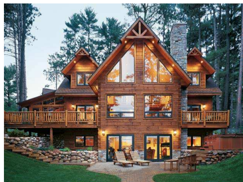
Εικόνα 37: “Επεξεργασμένο” κορμόσπιτο (Milled or machine – profiled log house)
