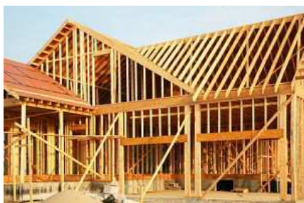
Εικόνα 41: Κατασκευή από προκατασκευασμένα ξύλινα πλαίσια (Timber Framed House)
