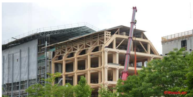
Εικόνα 27: Κεντρικά γραφεία της Tamedia AG, φάση κατασκευής (επτάοροφη ξύλινη κατασκευή)
