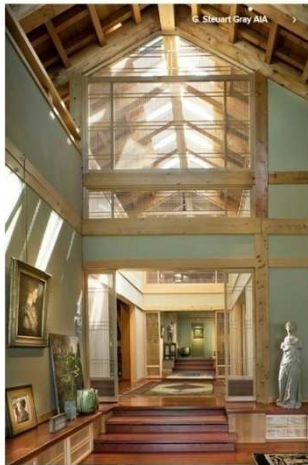
Εικόνα 20: Ανοίγματα και διαφάνεια στο σύστημα δοκού επί στύλου
