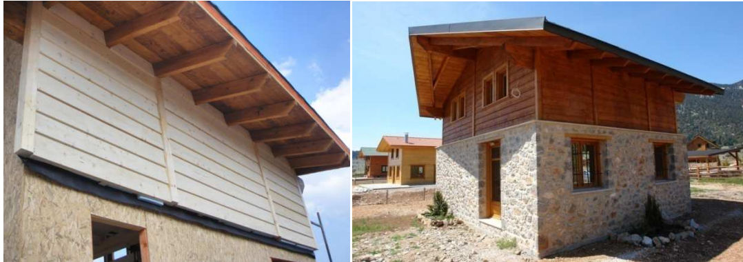
Εικόνα 22: Σύστημα με ελαφρύ και πυκνό ξύλινο σκελετό σε φάση κατασκευής Β'
