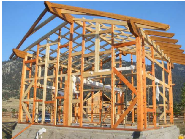
Εικόνα 20: Ανοίγματα και διαφάνεια στο σύστημα δοκού επί στύλου
