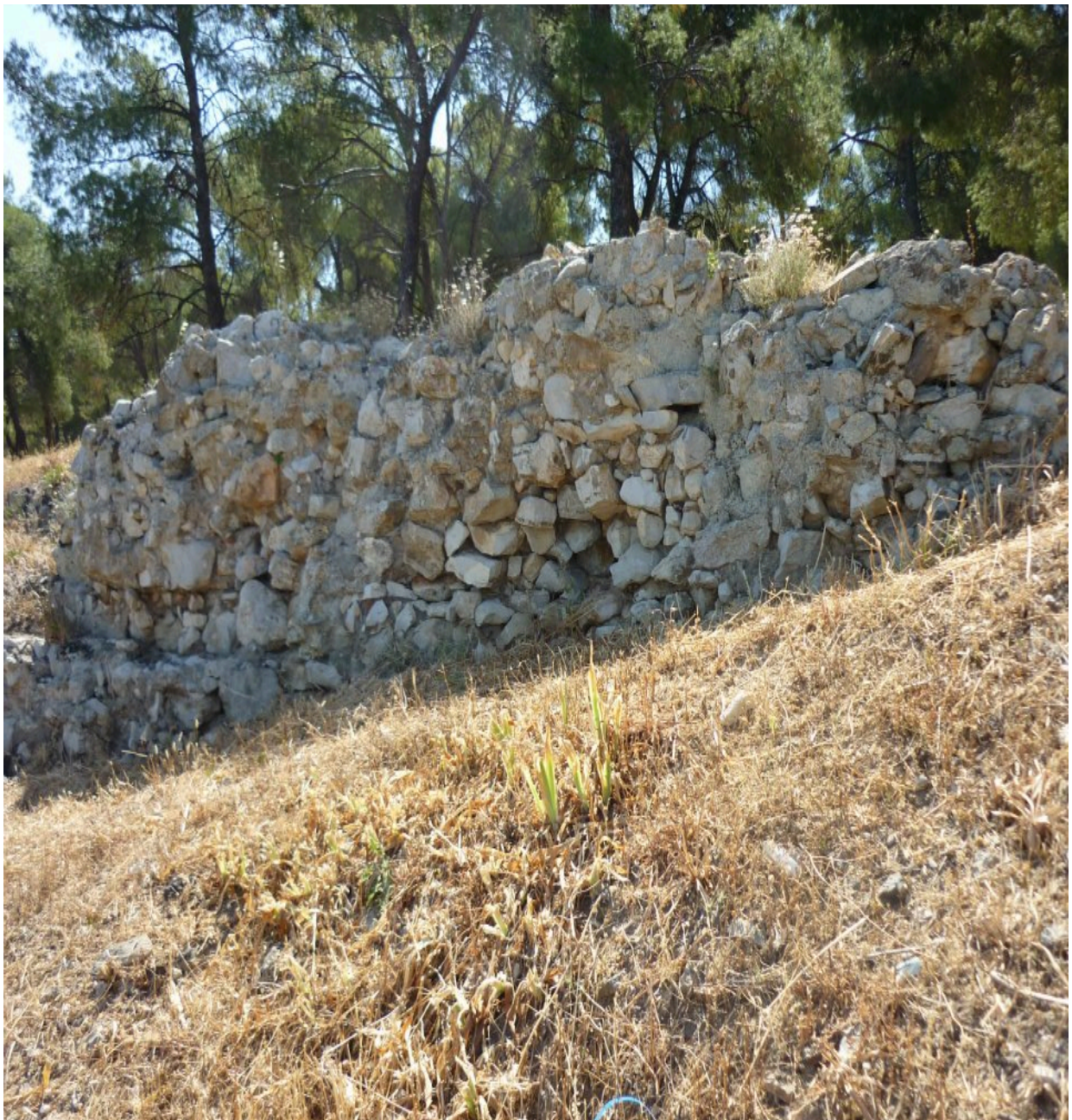
φωτογραφία 2, τμήμα τείχους στη νότια πλευρά του Μπισσιού μετά τον άγιο Γιάννη.Οι ογκόλιθοι της εξωτερικής επιφάνειας έχουν καταπέσει στη θάλασσα.
