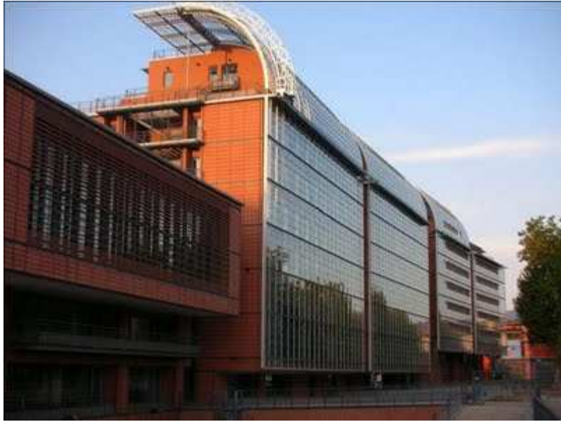
Εικόνες 5.15, 5.16 Κτήριο γραφείων με διπλό κέλυφος στη Λυών και λεπτομέρειά του. Αρχιτέκτονας: Renzo Piano
