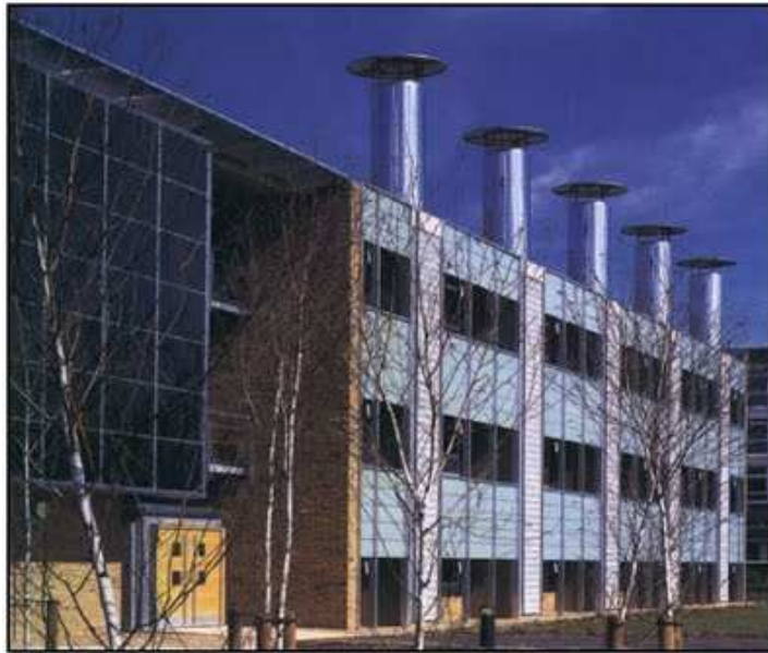
Εικόνα 5.11. Ηλιακές καμινάδες στο Building Research Establishment, Watford, United Kingdom (Feilden Clegg Architects, 1996)
