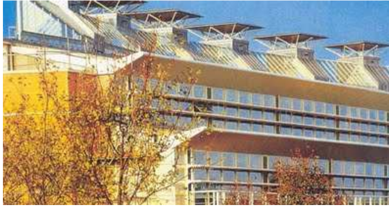
Εικόνα 5.13. IONICA, Κτήριο Γραφείων στο Cambridge - καμινάδες αερισμού (Αρχιτ: R. H.Partnership, 1994)
