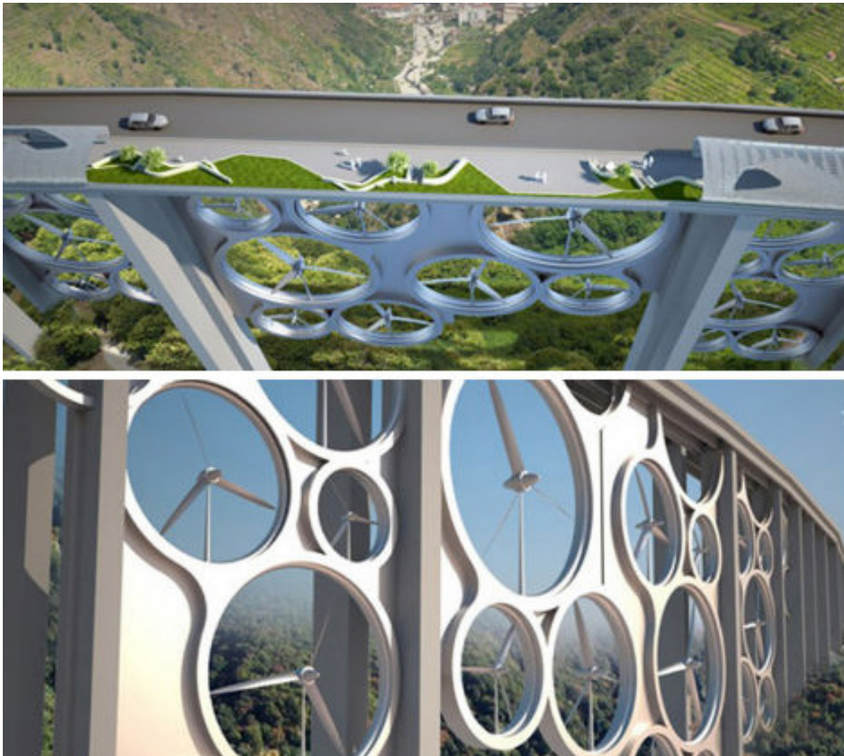
εικ. 1.27 Α/γ ενταγμένες σε οδογέφυρα πηγή: themindunleashed.org
