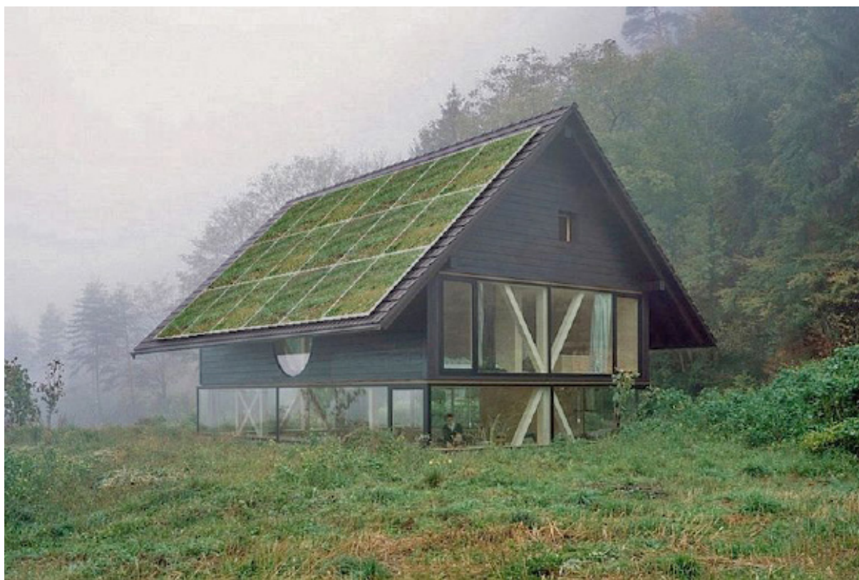
εικ. 2.5 Ηλιακοί συλλέκτες που έχουν σχεδιαστεί για να μοιάζουν με φυτεμένο δώμα πηγή : Courtesy Sistine Solar
