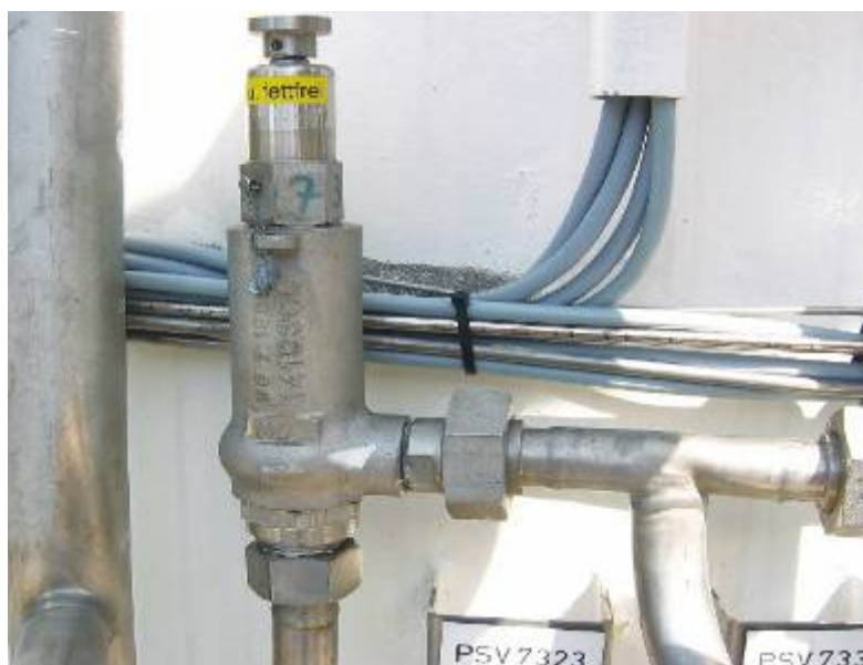
Σχήμα: 3.20-2: Συνδεδεμένη ασφαλιστική βάνα
