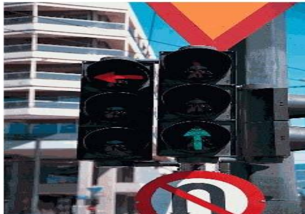
Εικόνα 1.8: Τυπική μορφή φωτεινού σηματοδότη (βέλη πορείας).
