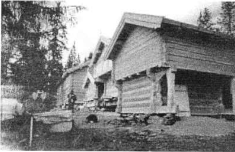
Σχ.28 γ Κορμόσπιτα που κατασκεύασαν οι Νορβηγοί για τις ανάγκες της χειμερινής ολυμπιάδας του 1993
