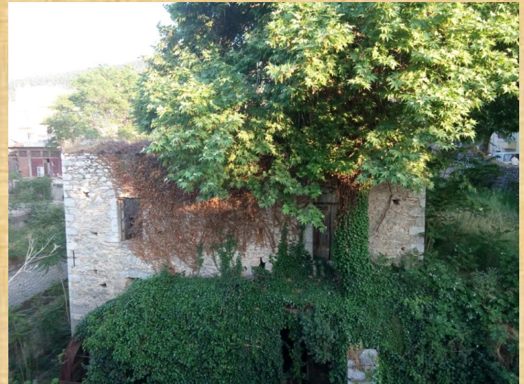
Βόρεια όψη κτηρίου
