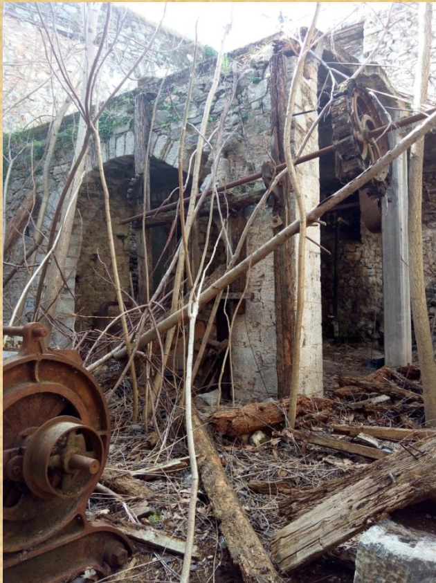
Πλάκα οπλισμένου σκυροδέματος
