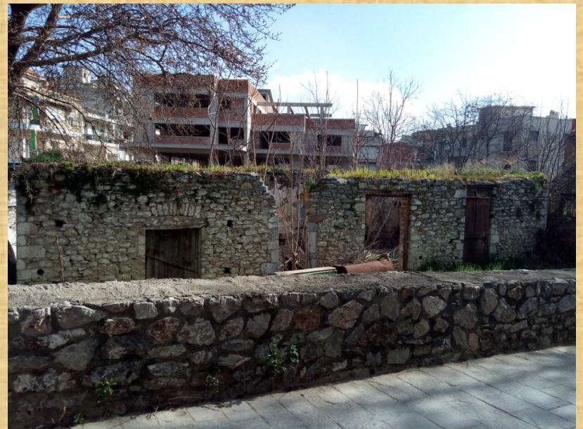
Δυτική όψη κτηρίου
