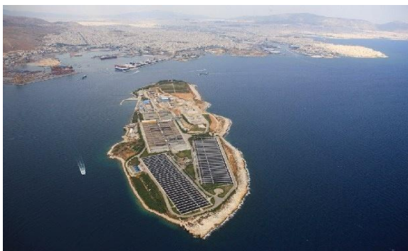
Εικόνα 3: Το Κέντρο Επεξεργασίας Λυμάτων της Ψυτάλλειας.
