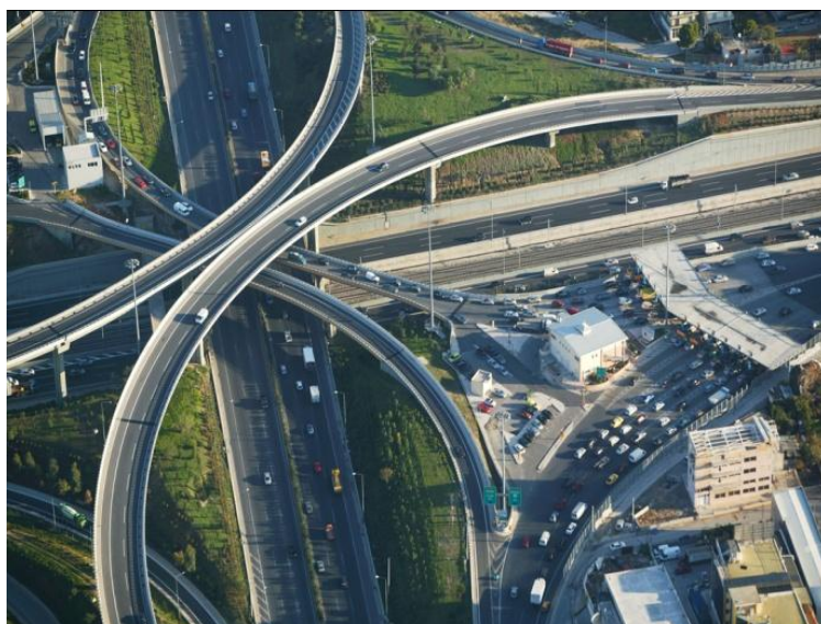
Εικόνα 1: Ανισόπεδος κόμβος της Αττικής οδού - Μεταμόρφωση.
