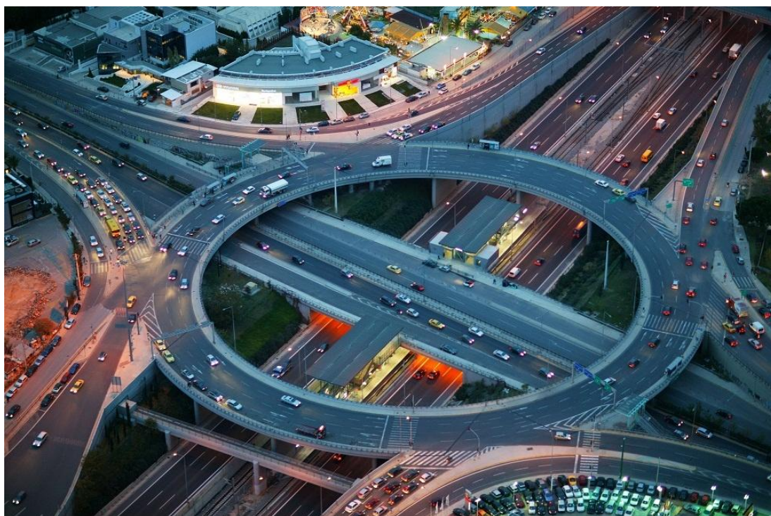
Εικόνα 6: Ανισόπεδος Κόμβος Αττικής Οδού Και Λεωφόρου Κηφισίας
