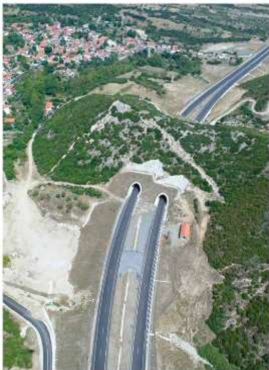
01. Ρεντίνα σήραγγα Βρασνών, Εγνατία οδός
