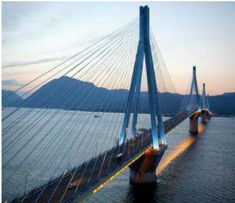
Γέφυρα Ρίου - Αντιρρίου
