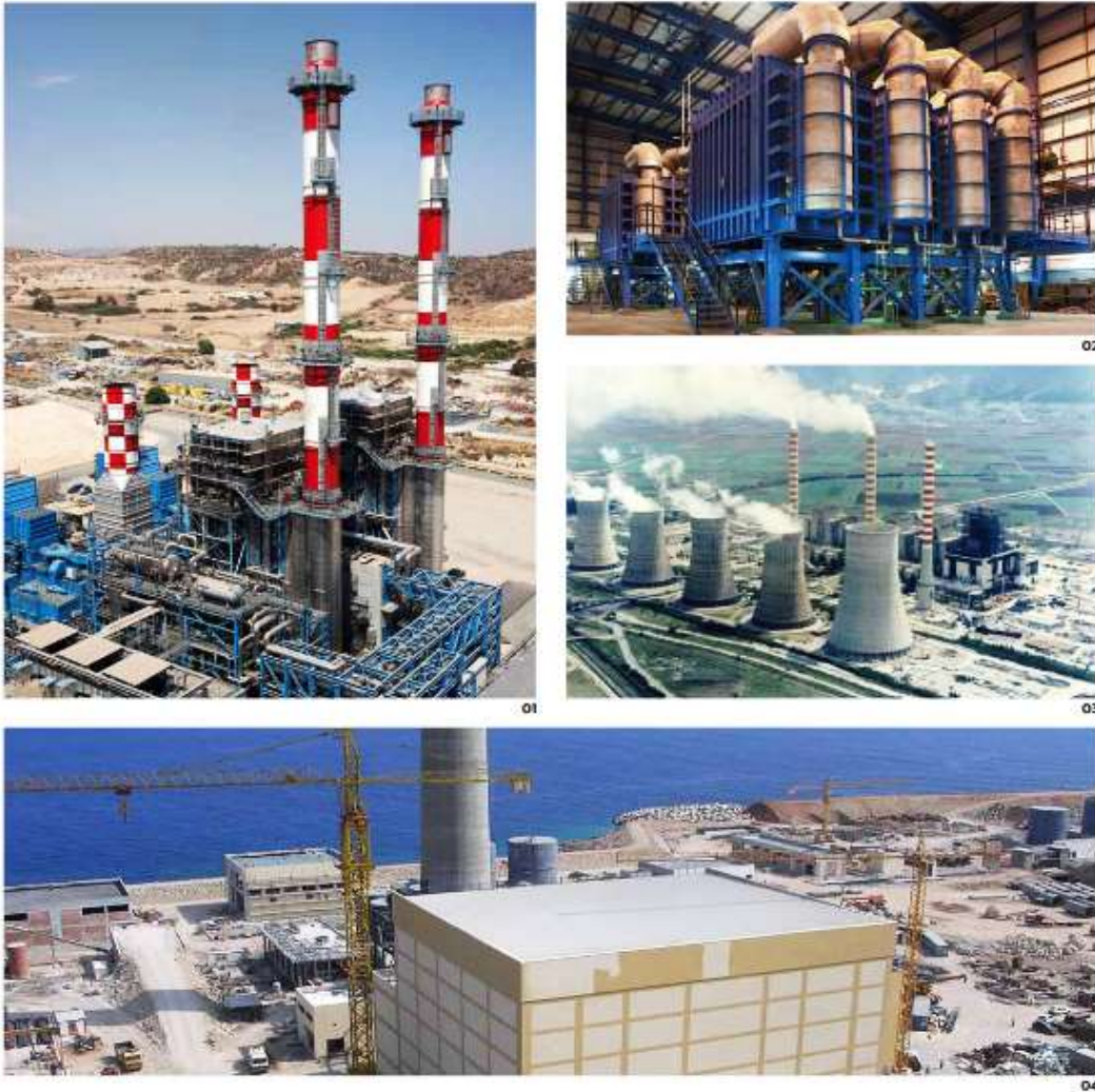
01. Μονάδα ηλεκτροπαραγωγής συνδυασμένου κύκλου 220 MW ΑΗΚ, Βασιλικός Κύπρου 02. Μονάδα ηλεκτροπαραγωγής συνδυασμένου κύκλου 220 MW ΑΗΚ, Βασιλικός Κύπρου 03. Θερμοηλεκτρικός σταθμός, Αγ. Δημήτριος, Κοζάνη 04. Ατμοηλεκτρικός σταθμός, Αθερινόλακκος, Κρήτη
