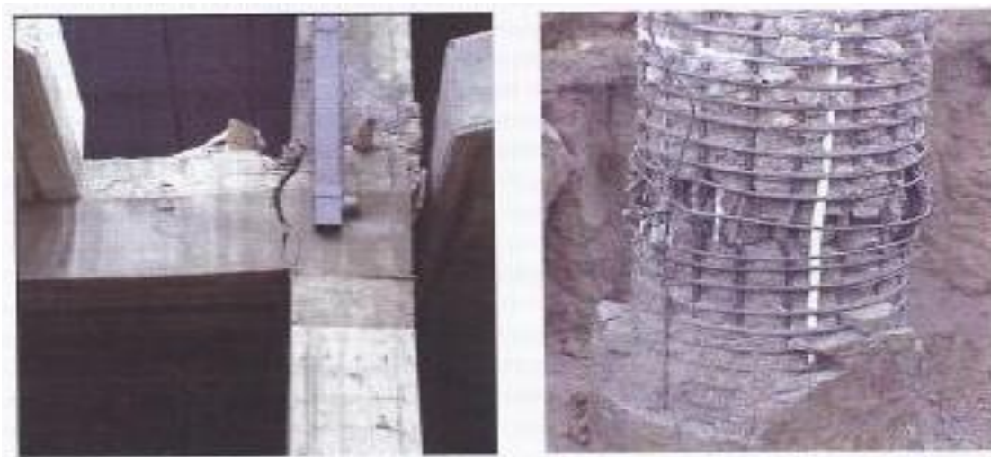
Εικόνα 2.1 Ζημιές στις πλαστικές αρθρώσεις [20]
