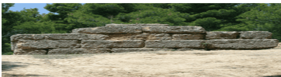
Φωτογραφία 1α: τοίχος Βιλατούρι Πάρνηθας.
