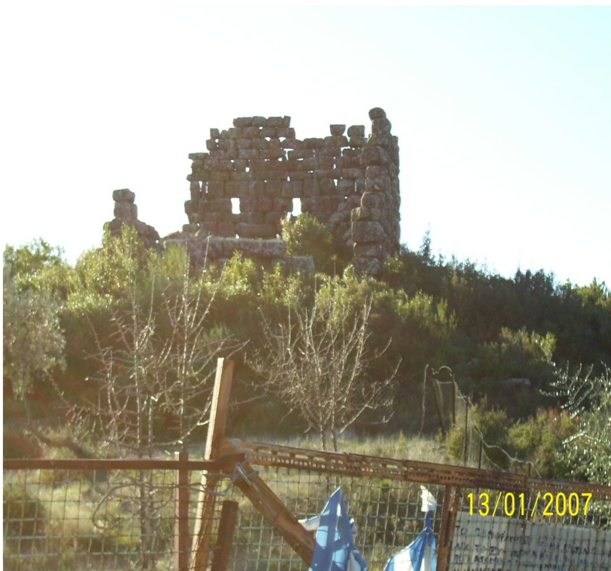
Φωτογραφία 21: βόρεια άποψη
