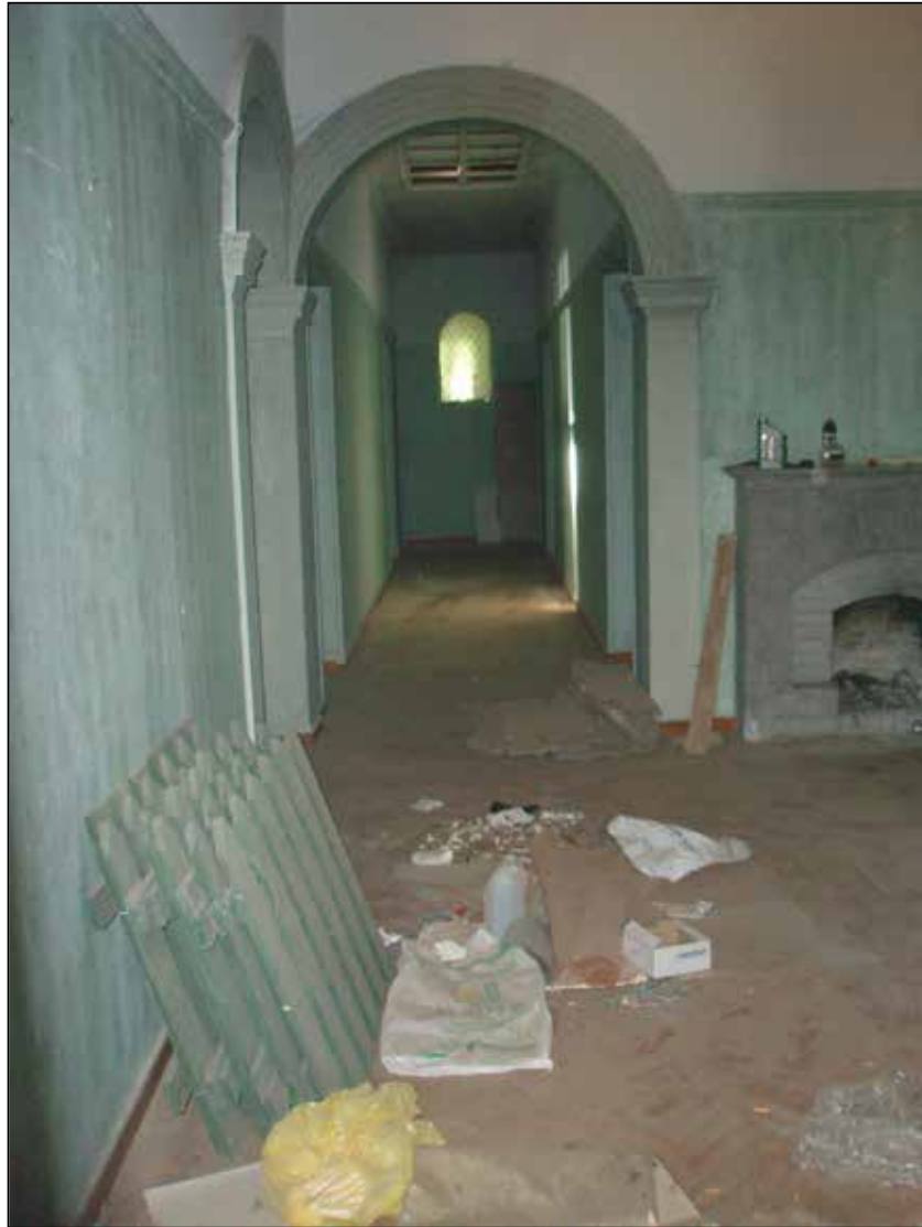
Εικόνα 83. Μέρος του εσωτερικού του κτιρίου όπως είναι σήμερα.
