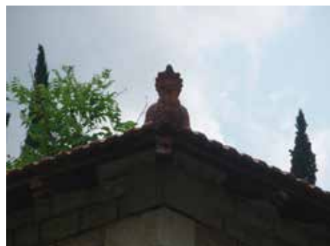
Εικόνα 84. Ακροκέραμο της στέγης.
