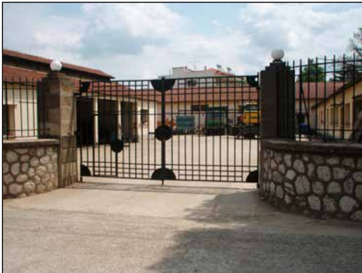
Εικόνα 41. Η σιδερένια δίφυλλη πόρτα της εισόδου του μηχανουργείου.
