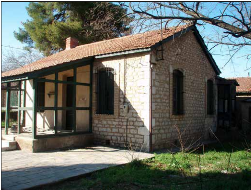
Εικόνα 57. Άποψη του κτιρίου V.
