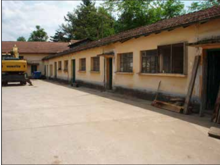
Εικόνα 42. Η εσωτερική αυλή του μηχανουργείου. Διακρίνεται κτίριο αποθηκών.
