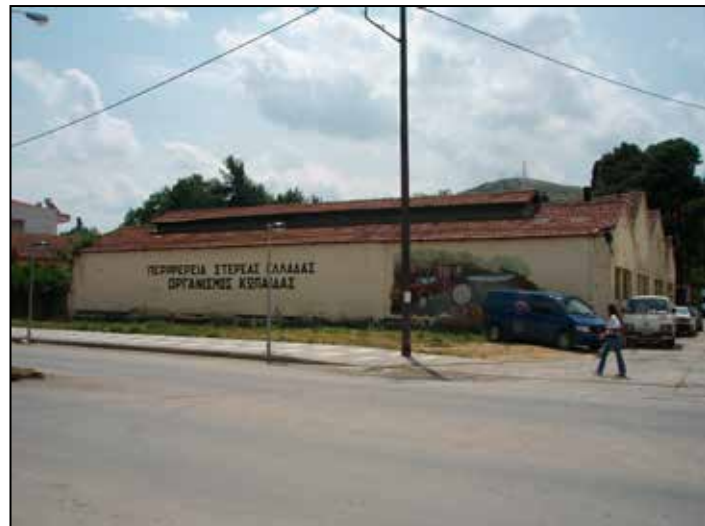
Εικόνα 43. Άποψη του μηχανουργείου από τον κεντρικό δρόμο.
