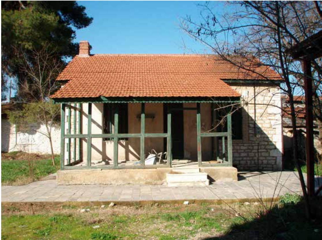
Εικόνα 114. Η νότια όψη του κτιρίου V.
