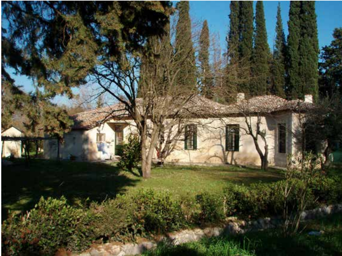
Εικόνα 65. Άποψη του κτιρίου C.
