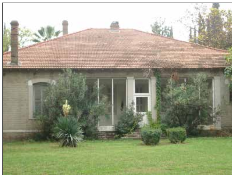
Εικόνα 99. Η δυτική όψη του κτιρίου. Διακρίνεται η σκεπαστή βεράντα.
