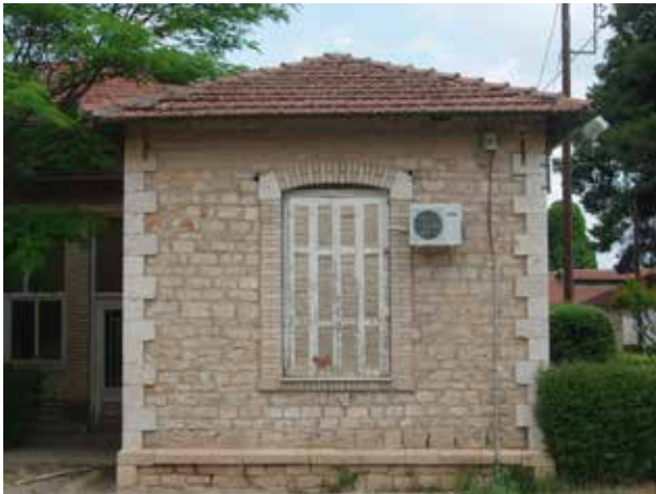
Εικόνες 49, 50. Λεπτομέρεια κουφώματος και η κεντρική είσοδος του κτιρίου
