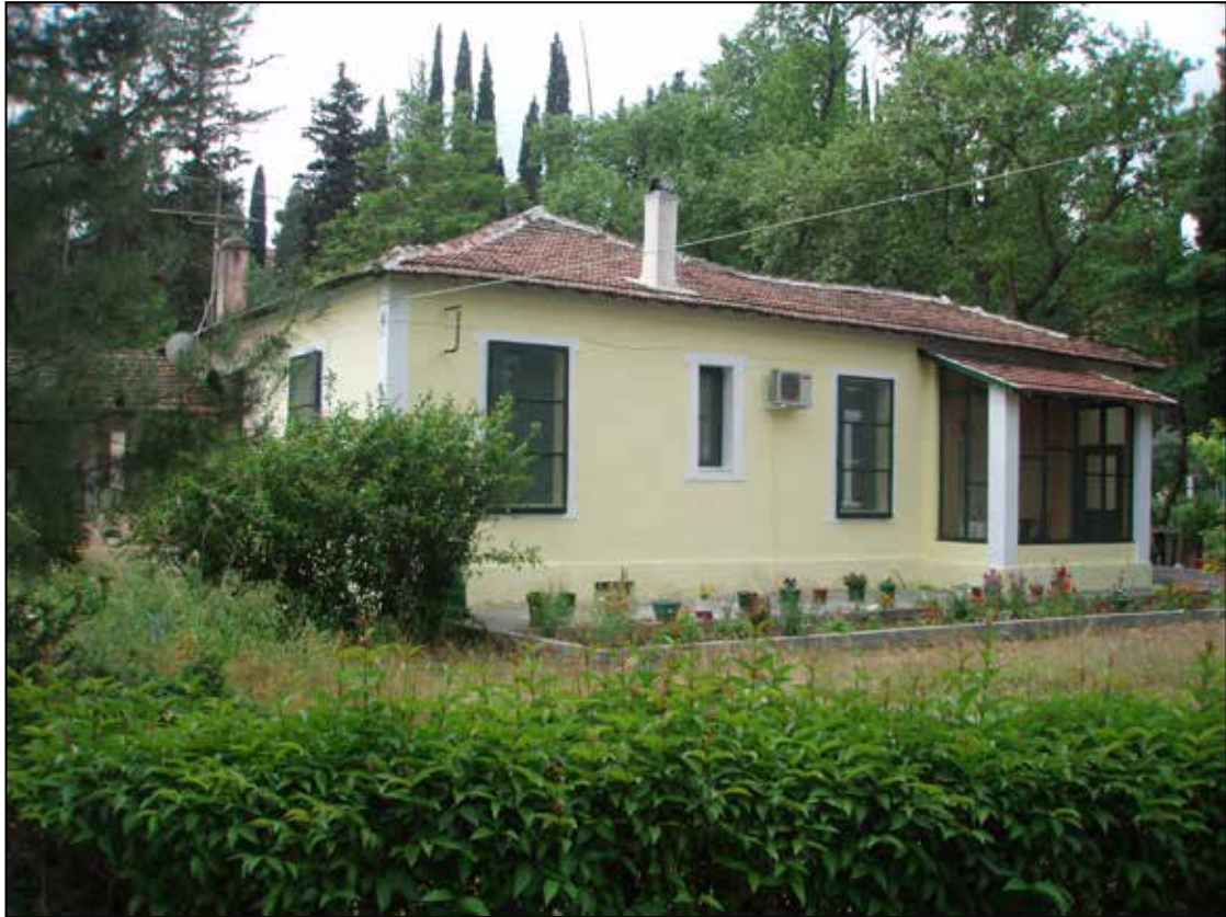
Εικόνα 71. Βόρεια όψη του κτιρίου D.
