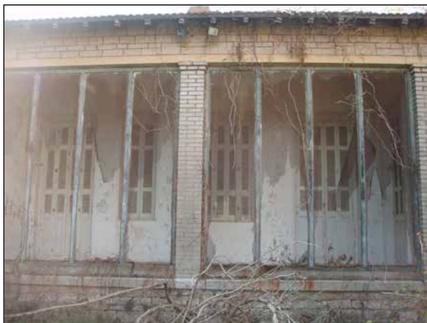
Εικόνα 98. Η σκεπαστή βεράντα της ανατολικής πλευράς του κτιρίου Ε.
