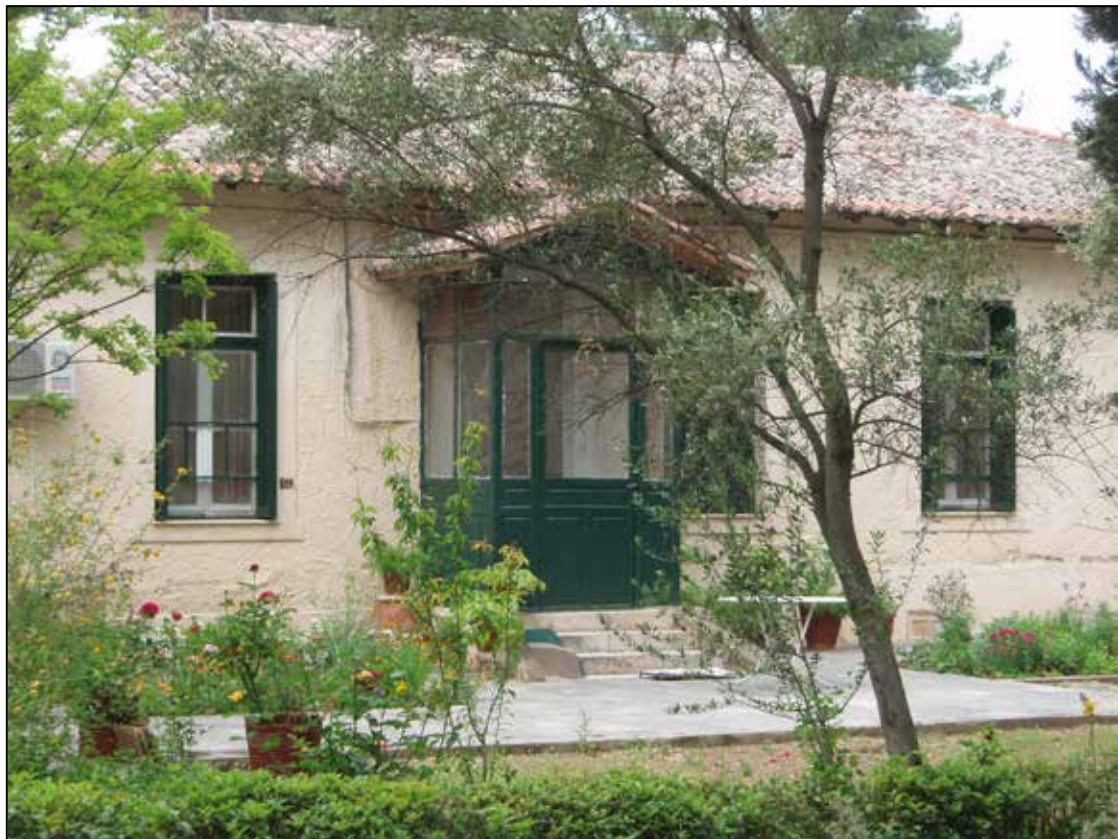
Εικόνα 70. Η κύρια όψη του κτιρίου C όπου διακρίνεται και η χαρακτηριστική σκεπαστή είσοδος.
