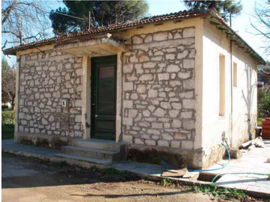
Εικόνα 62. Η κύρια όψη του κτιρίου Τ που παλαιότερα στέγαζε το ταχυδρομείο.
