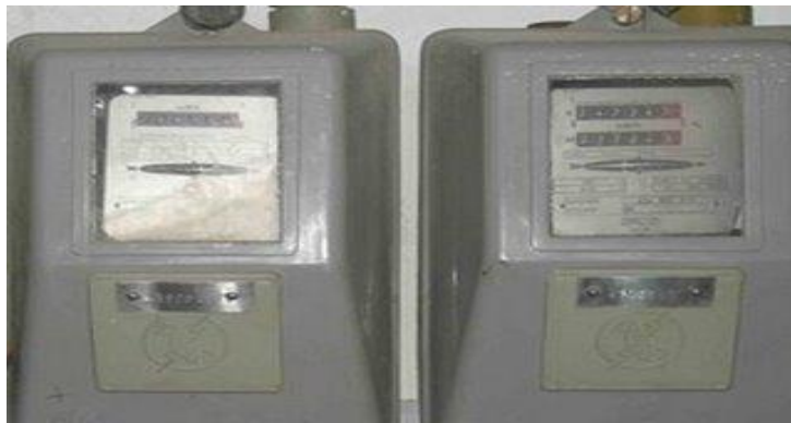
Εικόνα 1.1. Επαγωγικός Μετρητής ηλεκτρ. Ενέργειας
