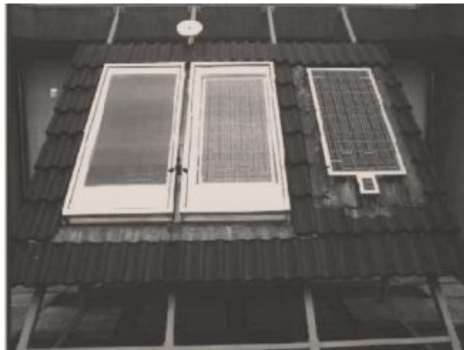
Εικόνα 9: Στην εικόνα διακρίνονται ένα τυπικό φωτοβολταϊκό, ένας συλλέκτης και ένα υβριδικό φωτοβολταϊκό θερμικό σύστημα.
