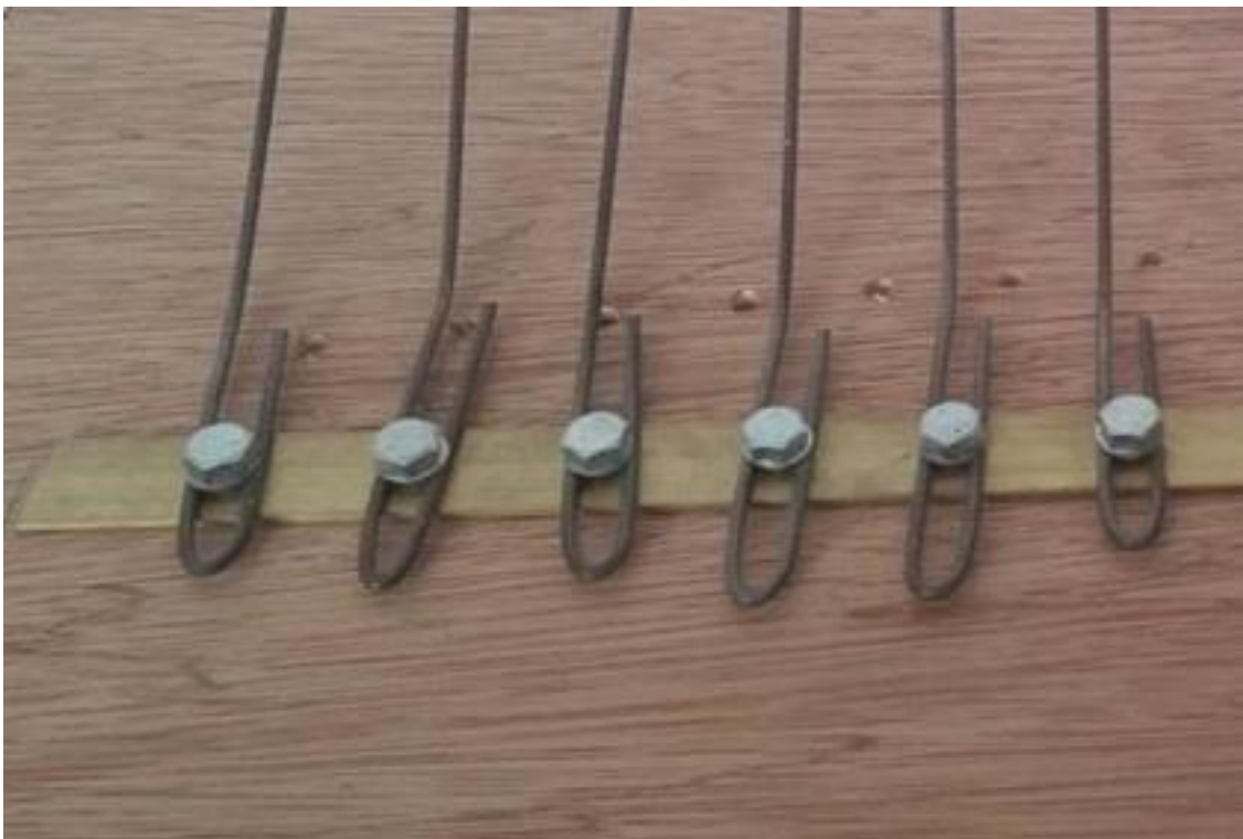
Εικόνα 2.7: Τοποθέτηση βάσης ελασμάτων
