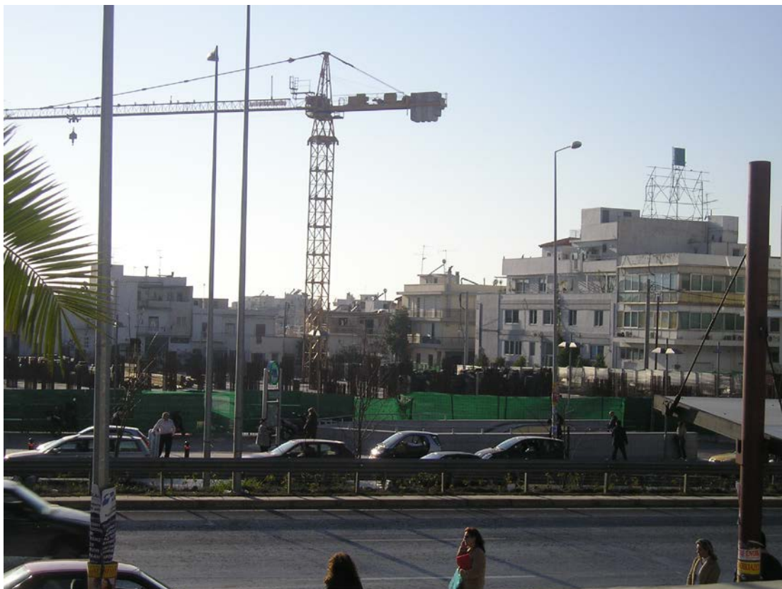
Εικόνα 23: Ο νέος χώρος στάθμευσης που κατασκευάζεται στο σταθμό του Αγίου Δημητρίου
