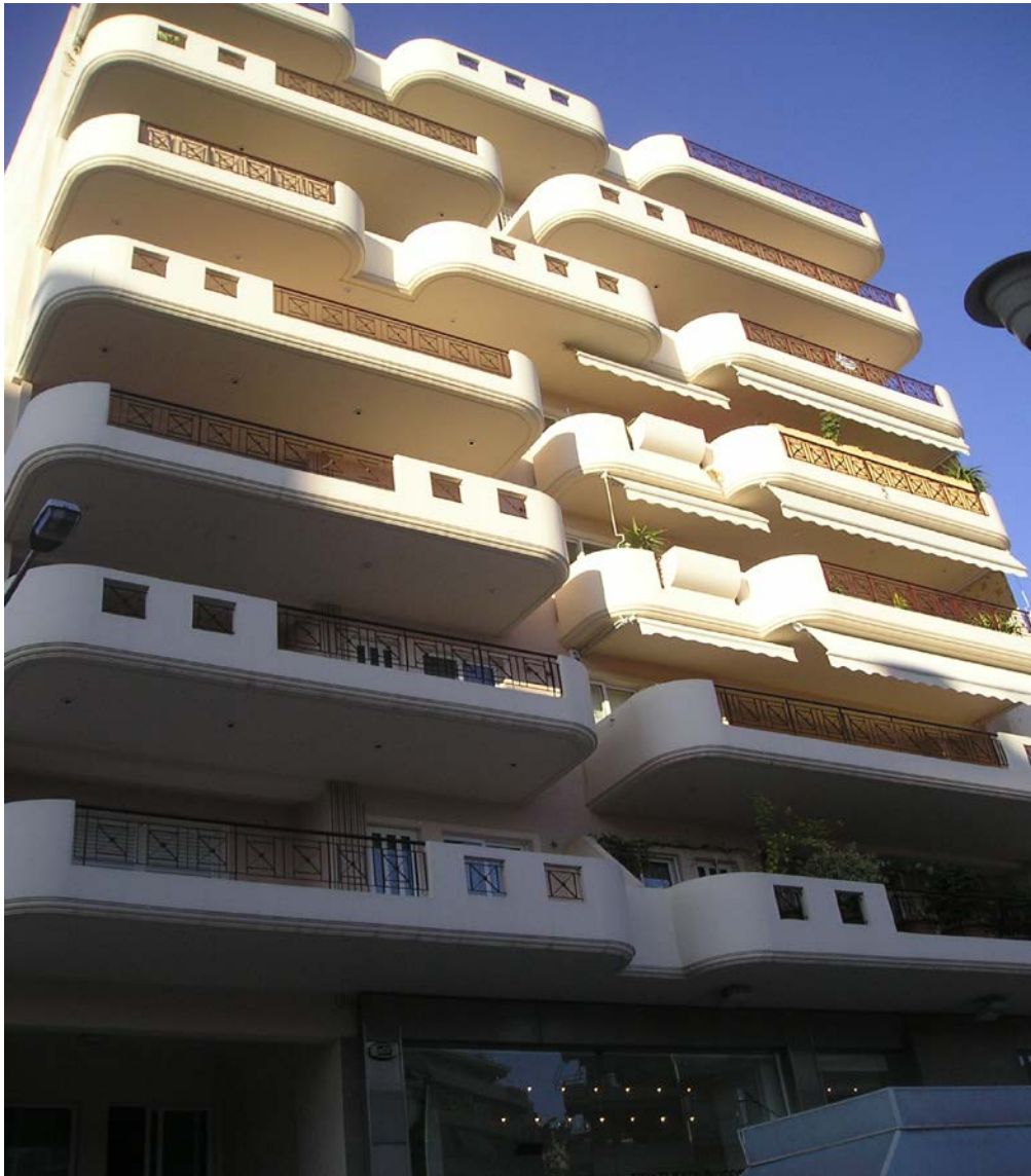
Εικόνα 16: Μια νέα πολυκατοικία στον πεζόδρομο της Κασομούλη
