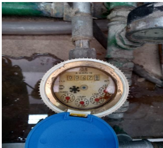
Εικόνα 2:Μηχανικός ογκομετρητής
