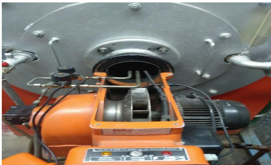
Εικόνα 16 :Ανοιχτός καυστήρας
