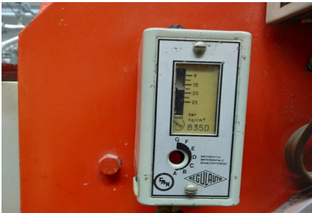
Εικόνα 23: Πρεσοστάτης υπερπίεσης
