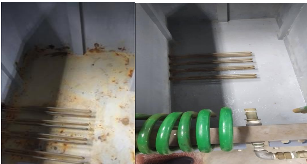
Εικόνα 11 : Δεξαμενή πριν και μετά
