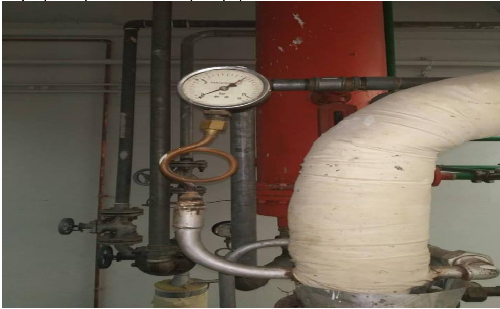
Εικόνα 36: Μανόμετρο εισόδου ατμοστροβίλου
