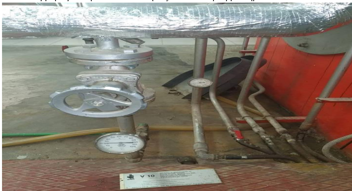
Εικόνα 32:Θερμόμετρα εισόδου και εξόδου υ/θ
