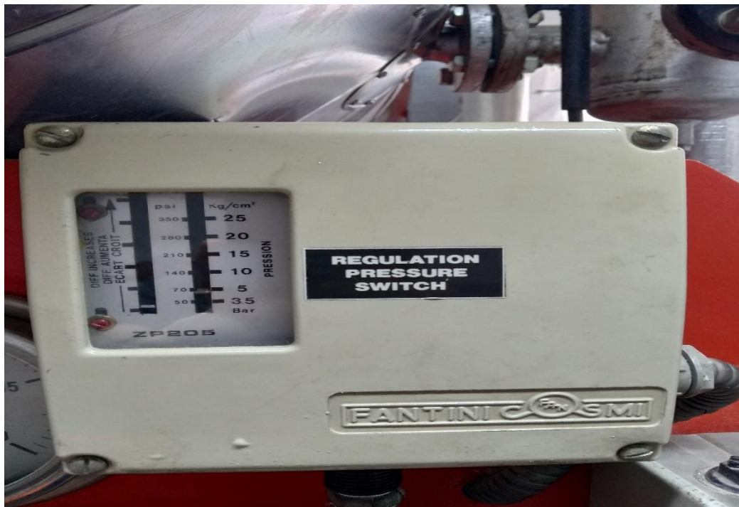
Εικόνα 18: Διαφορικός πρεσοστάτης
