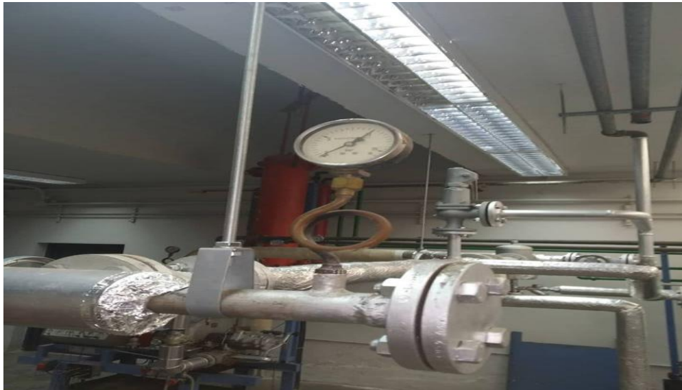
Εικόνα 35: Μανόμετρο εξόδου ατμοϋδροθαλάμου
