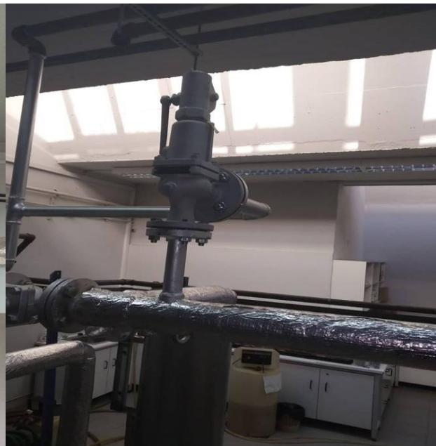
Εικόνα 29: Βαλβίδα αφυπερθερμαντήρα
