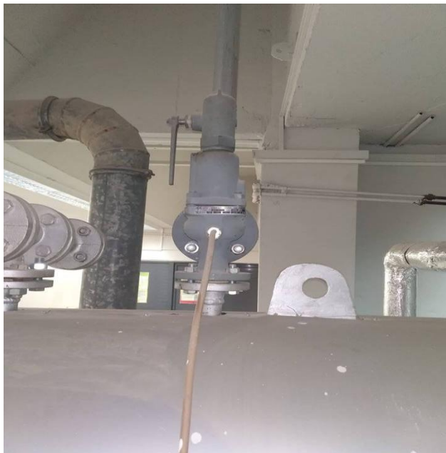
Εικόνα 28: Βαλβίδα ατμοδροθαλάμου
