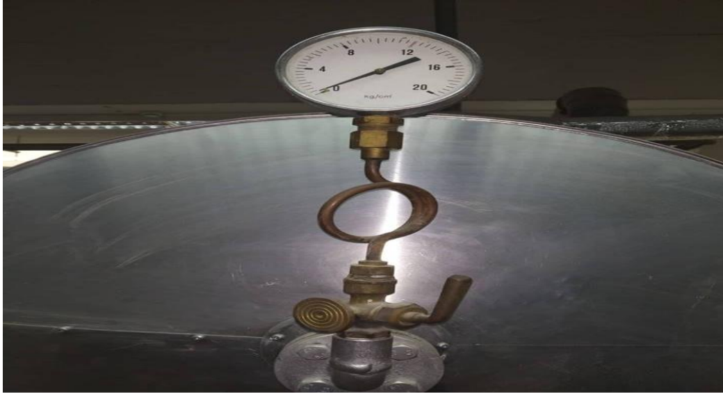
Εικόνα 34: Μανόμετρο ατμοϋδροθαλάμου
