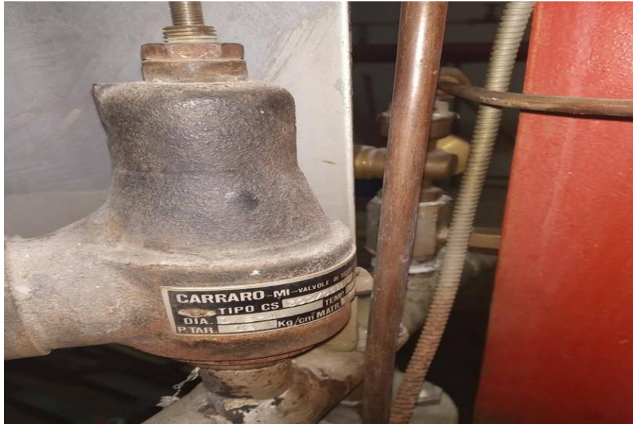
Εικόνα 27: Ασφαλιστική βαλβίδα υπερπίεσης
