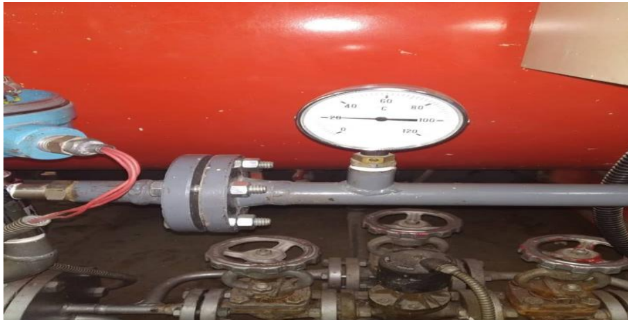
Εικόνα 30: Θερμόμετρο εξόδου προθερμαντήρα
