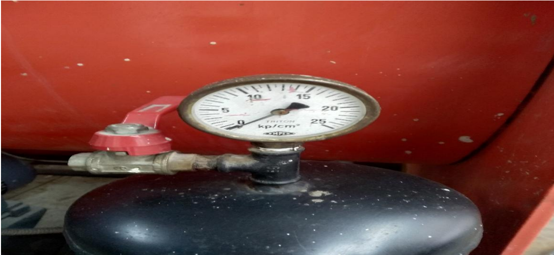
Εικόνα 33: Μανόμετρο αεροκώδωνα
