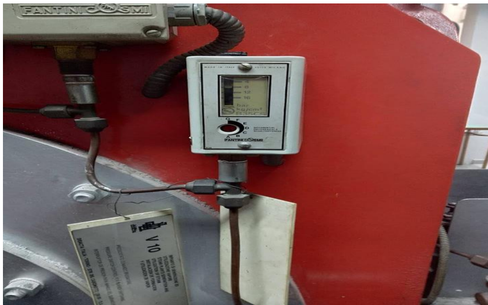
Εικόνα 24: Δεύτερος πρεσοστάτης
