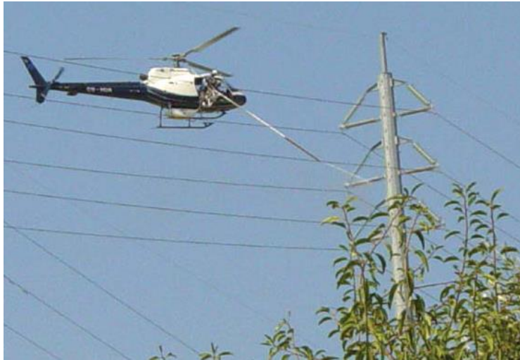
Εικόνα 16: Καθαρισμός Γραμμής Μεταφοράς 150kV του Συστήματος Κρήτης, υπό τάση, με ελικόπτερο
