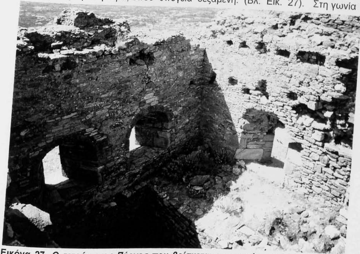
Εικόνα 27. Ο τετράγωνος Πύργος που βρίσκεται στη γωνία μεταξύ του νοτίου τείχους και του τμήματος αυτού που κατεβαίνει από τη «Ρόκα». Εδώ διακρίνεται και η υπόγεια δεξαμενή.
