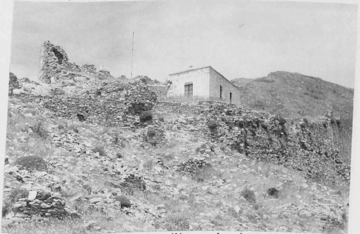
Εικόνα 17. Τμήμα του εσωτερικού του Κάστρου. Διακρίνεται ο από Δ. προς Α. τοίχος ο οποίος σχηματίζει ταφ με το Β.Α. τμήμα του τείχους και ο ναός του Προφήτη Ηλία.
