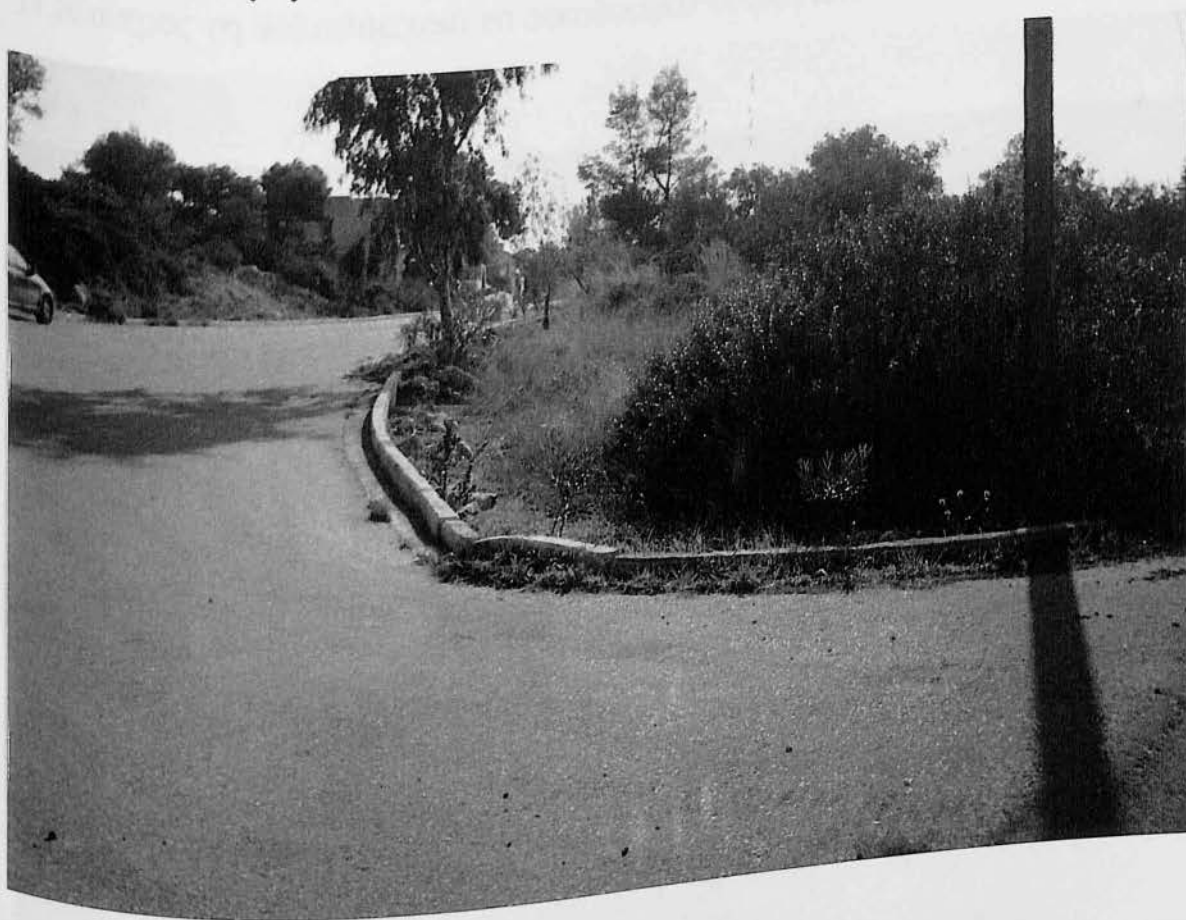
Διασταύρωση του δρόμου 42 με το δρόμο 47.
