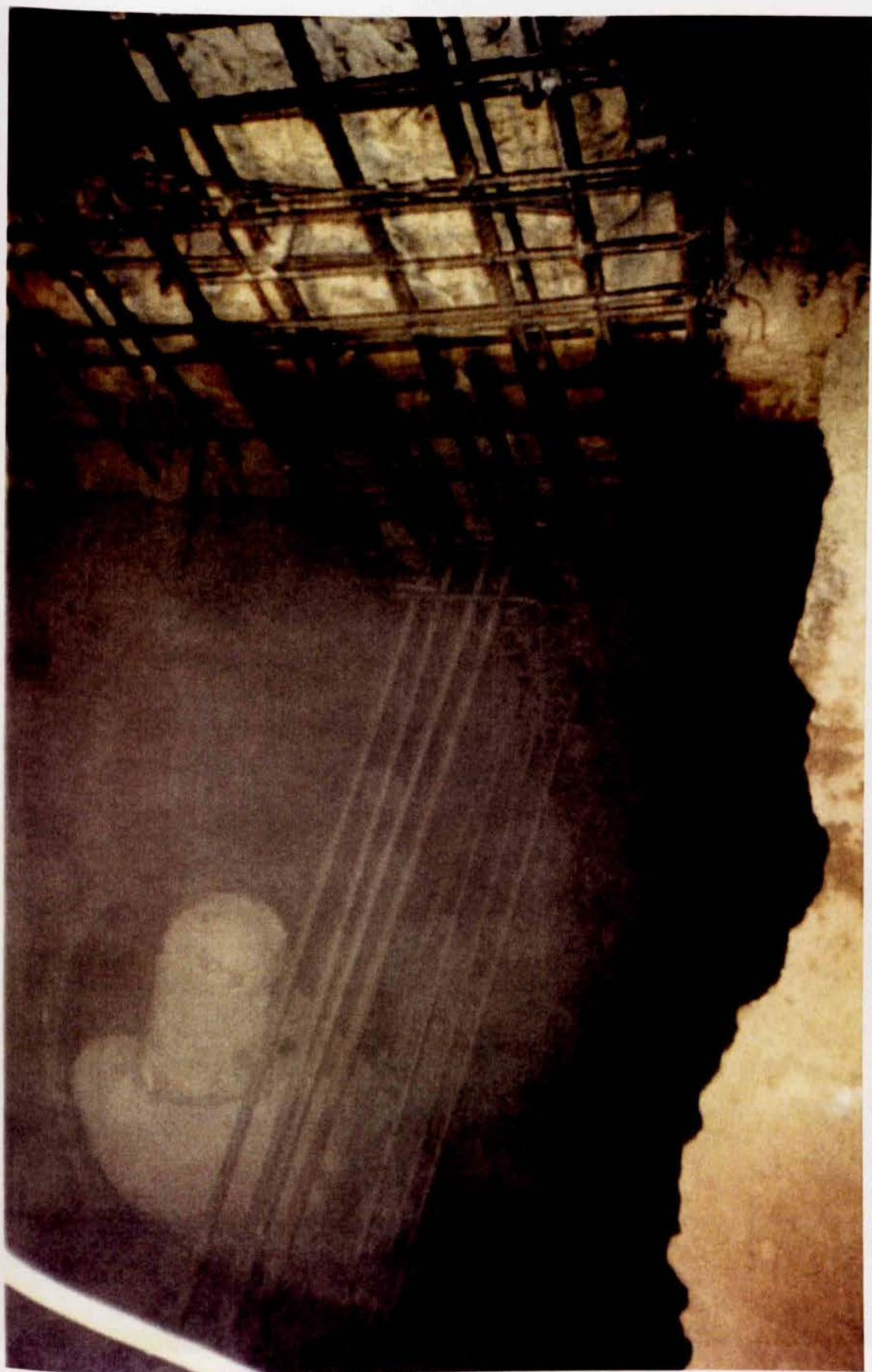
Εικόνα 31: Υποστύλωμα και αναμονές για συνδετήρια δοκό. Στιγμή σκυροδέτησης.
