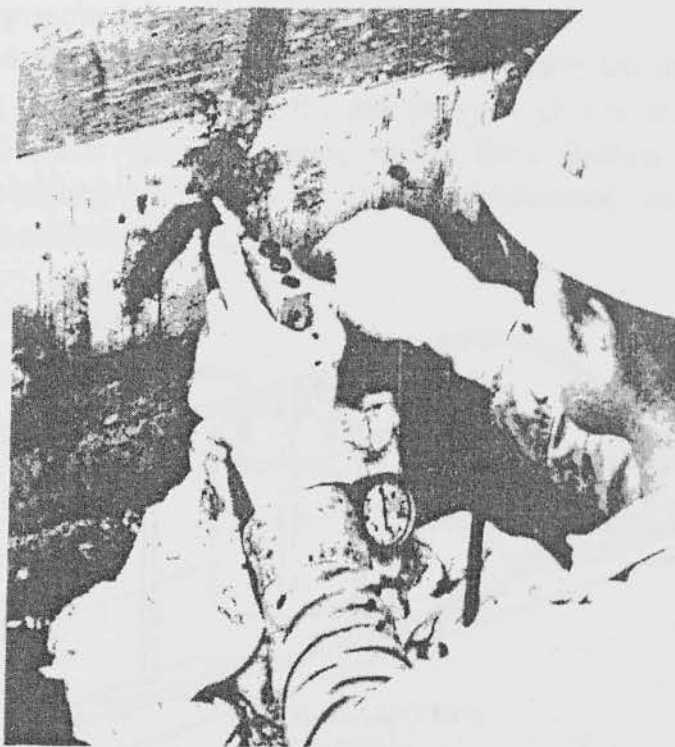
Σχ.4.12. Κλείσιμο ρωγμής με ένεση
