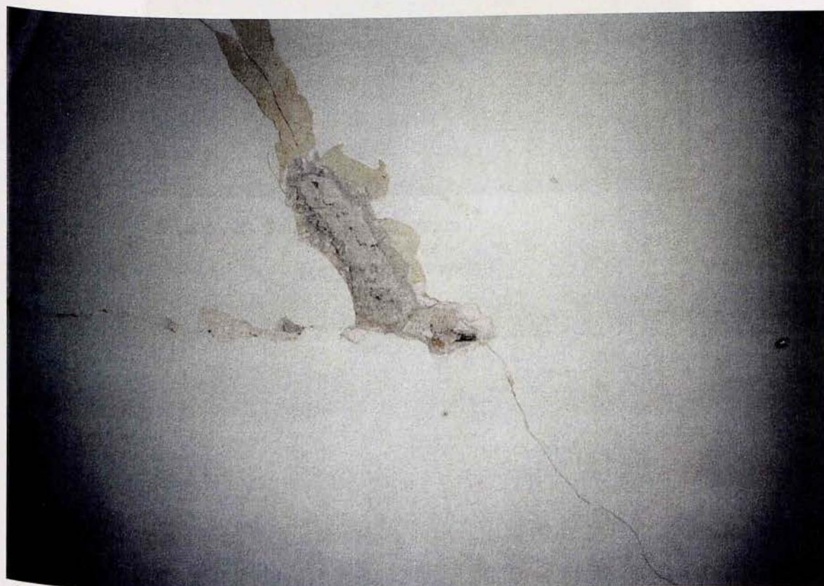
Εικόνα 8 : Τοιχίο σκάλας Ισογείου
