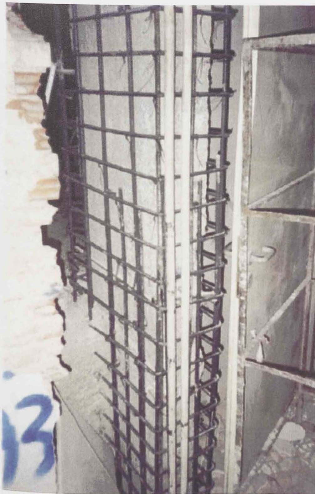
Εικόνα 17: Υποσύλωμα ισογείου Κ8
