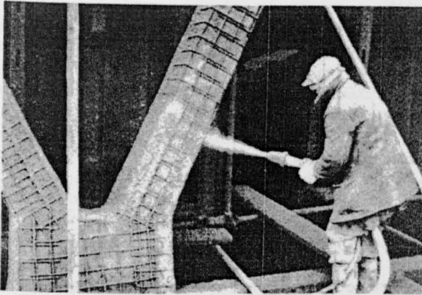
Σχ.4.9. Σκυροδέτηση υποστυλώματος
