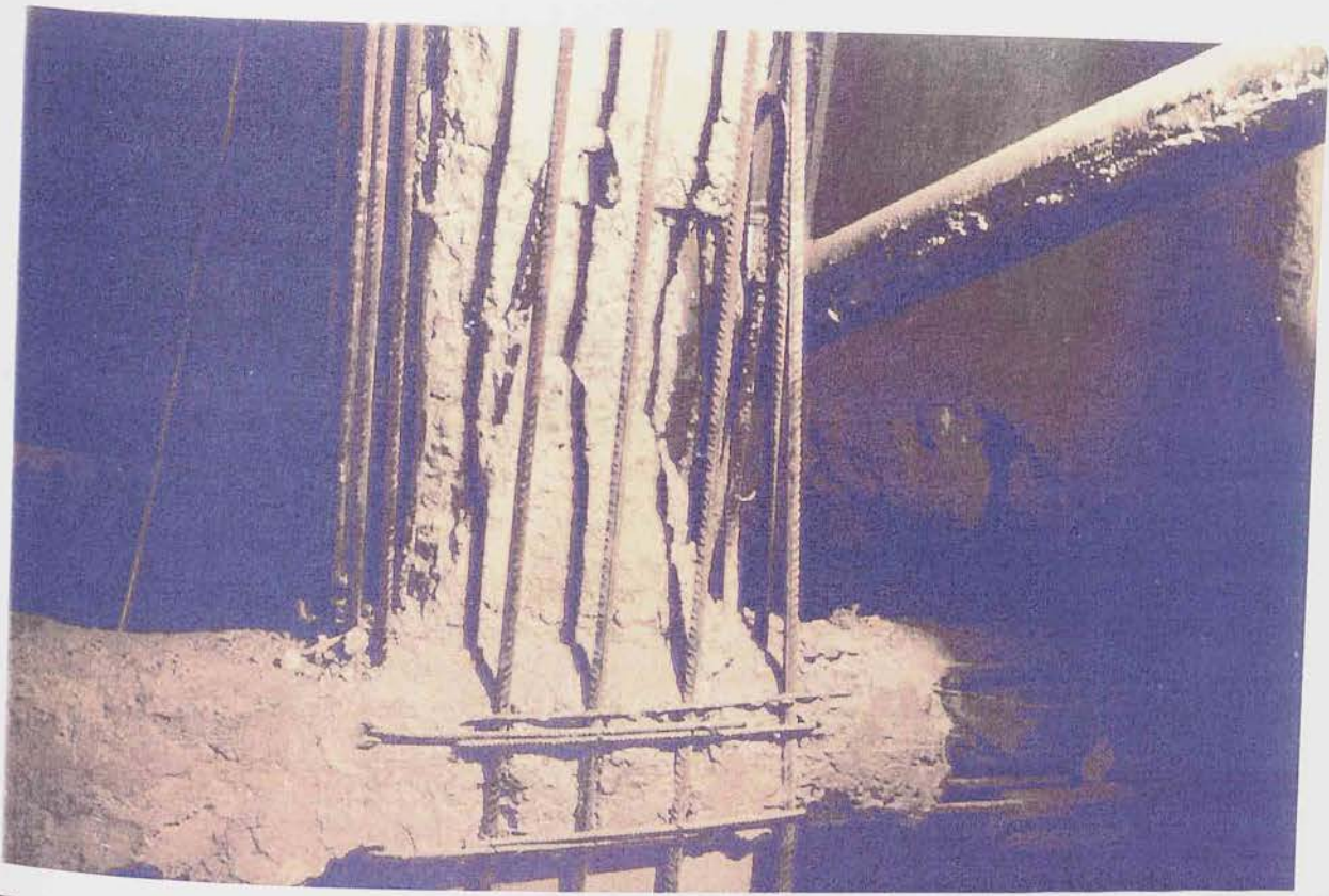
Εικόνα 40: Υποστύλωμα Υπογείου K12.
