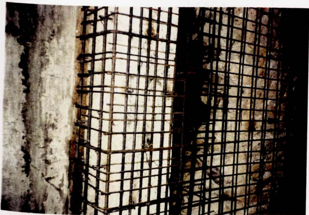
Εικόνα 24: Υποστύλωμα και τοιχίο υπογείου.
