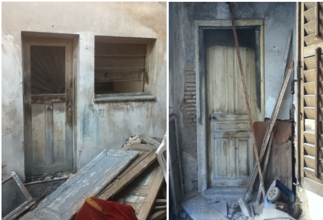
Εικόνα 10 Όλα τα κουφώματα και οι πόρτες του κτιρίου είναι κατασκευασμένα από ξύλο
