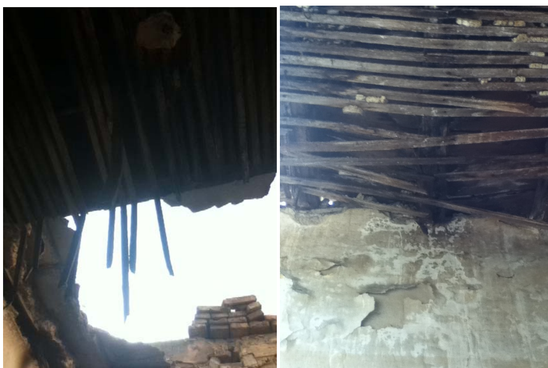
Εικόνα 9 Λεπτομέρειες από το τμήμα της στέγης που έχει καταρρεύσει
