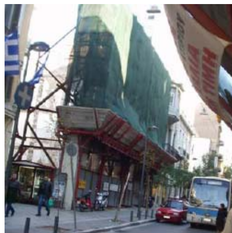
Εικόνα 15 Σκάφη περισυλλογής και ικριώματα
