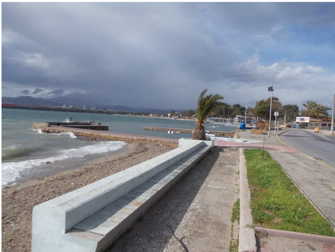
Εικόνα 24 Άποψη του παραλιακού μετώπου, όπου έχει μια καλή εικόνα
