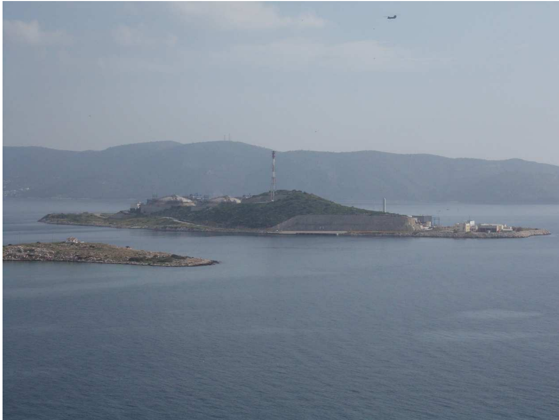
Εικόνα 60 Πανοραμική άποψη της νήσου Ρεβυθούσας και του Σταθμού Υγροποιημένου Φυσικού Αερίου
