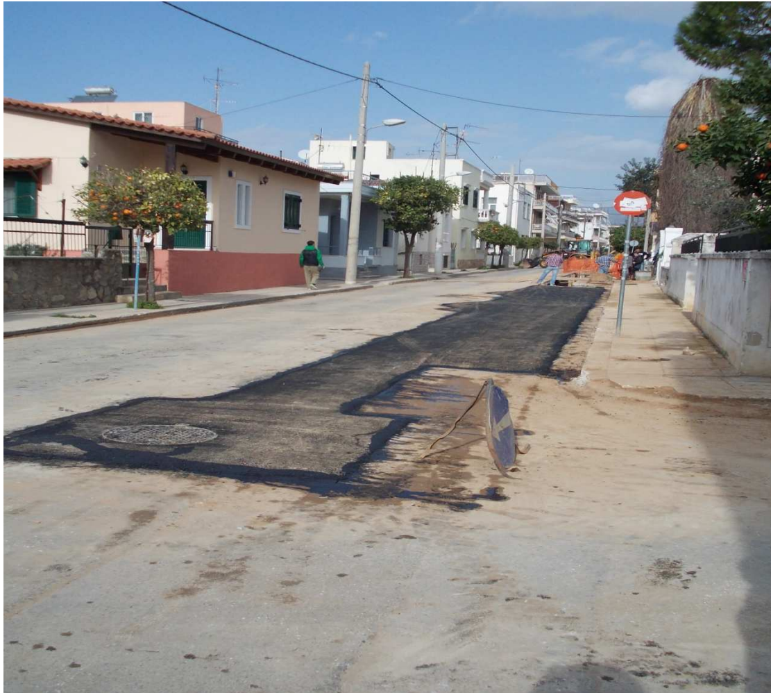
Εικόνα 16 Εργασίες εγκατάστασης αποχετευτικού συστήματος σε μια γειτονιά της Ελευσίνας
