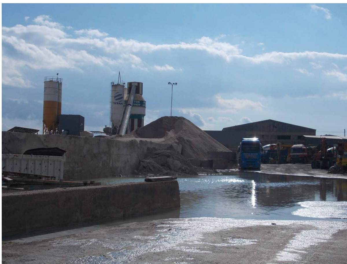
Εικόνα 46 Άποψη μέρους της βιομηχανικής ζώνης Μάνδρας
