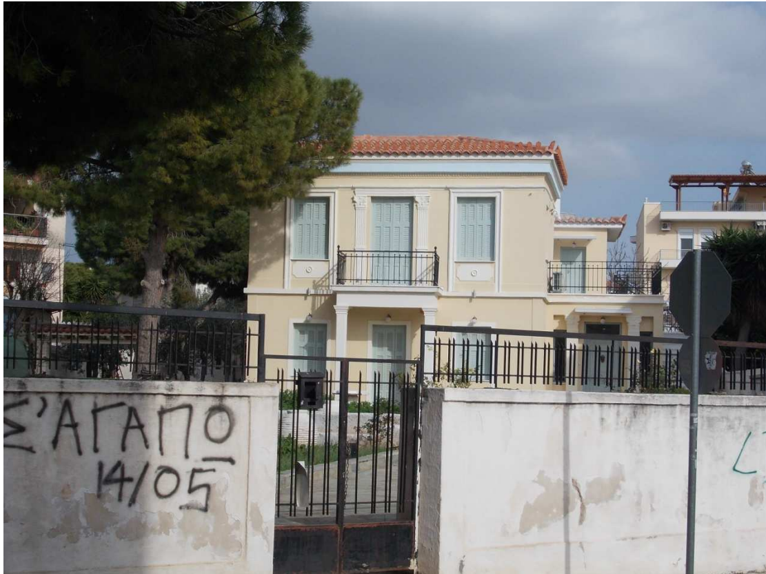
Εικόνα 7 Άποψη ενός νεοκλασικού και καλοδιατηρημένου κτιρίου.
