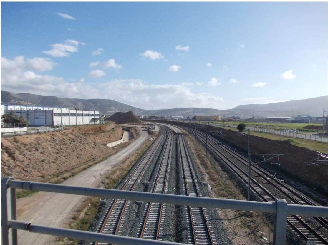
Εικόνα 30 Άποψη μέρους του νέου σταθμού του ΟΣΕ και των σιδηροδρομικών γραμμών
