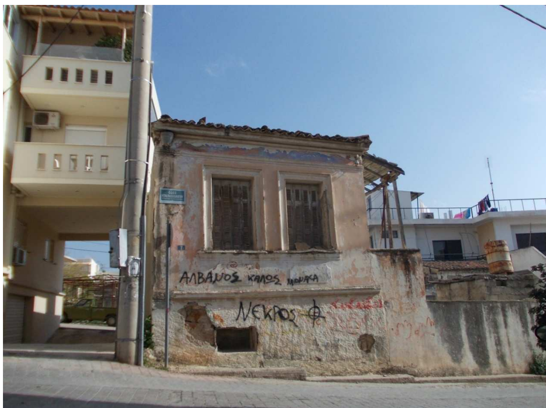
Εικόνα 57 Άποψη ενός εγκαταλελειμένου κτίσματος στα Μέγαρα
