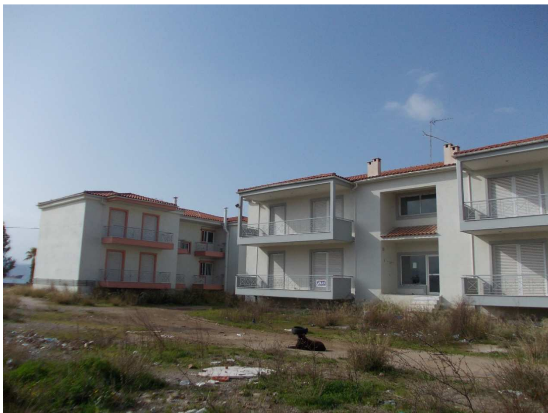
Εικόνα 10 Άποψη των νεόδμητων οικιών του ΟΕΚ, στο παραθαλάσσιο μέτωπο που παραμένουν εγκαταλελειμμένες.
