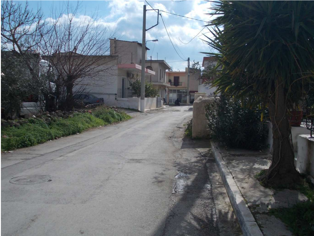
Εικόνα 41 Άποψη κτίσματος που καταλαμβάνει μέρος του οδοστρώματος
