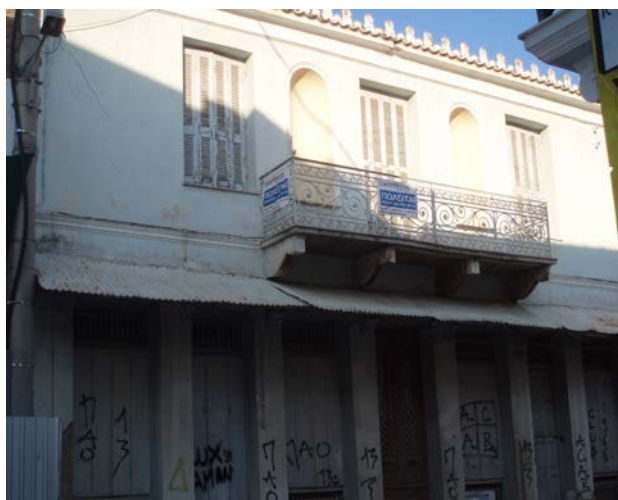
Άποψη από τις κόγχες του κτιρίου (Εικ.37)
