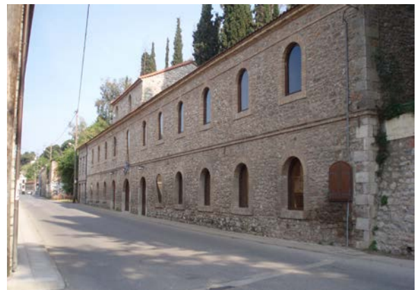
Σημερινή άποψη της αποθήκης (Εικ.70)
