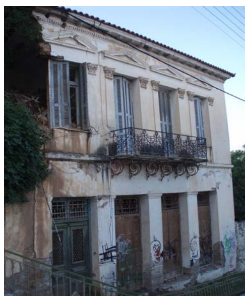
Σημερινή άποψη του εγκαταλελειμμένου σπιτιού (Εικ.29)
