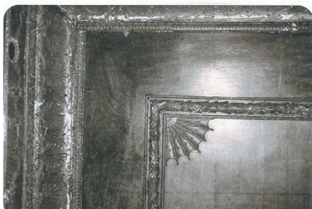
Ξύλινη διακόσμηση σε οροφή του κτιρίου (Εικ.52)
