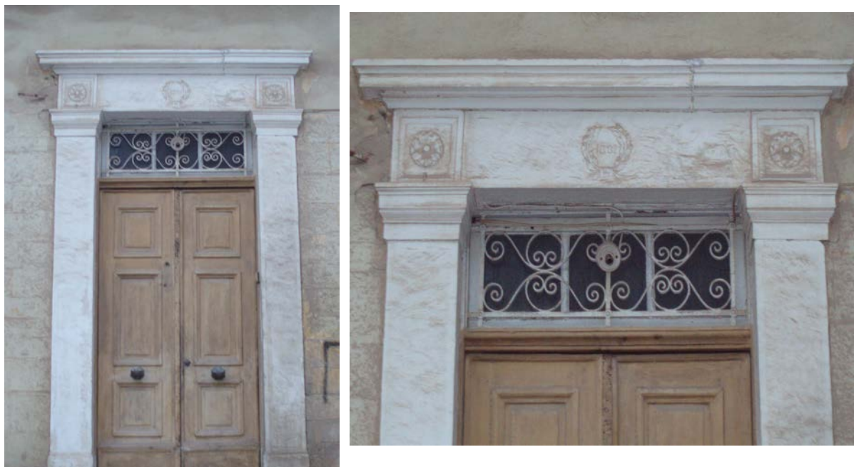
Η εξώπορτα του κτιρίου και η ροζέτα με την χρονολογία κατασκευής(Εικ.58)
