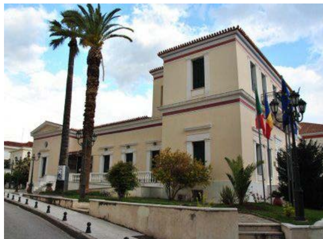
Σημερινή όψη (οδός Ανδρέου Λόντου) (Εικ.15)
