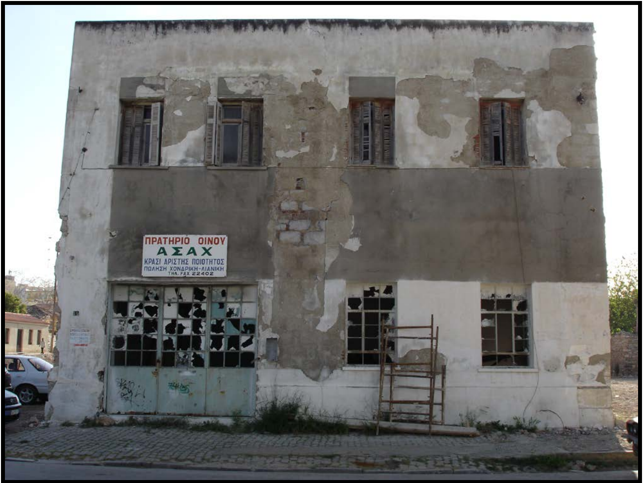
Εικόνα 19 : Υπάρχουσα Δυτική όψη κτιρίου
