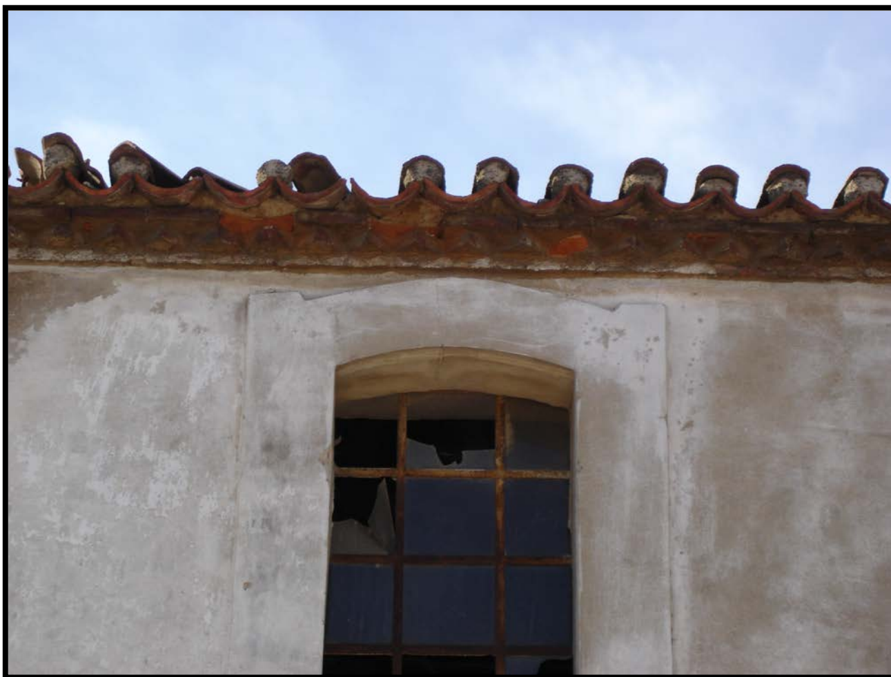
Εικόνα 14 : αποκόλληση κεραμιδιών
