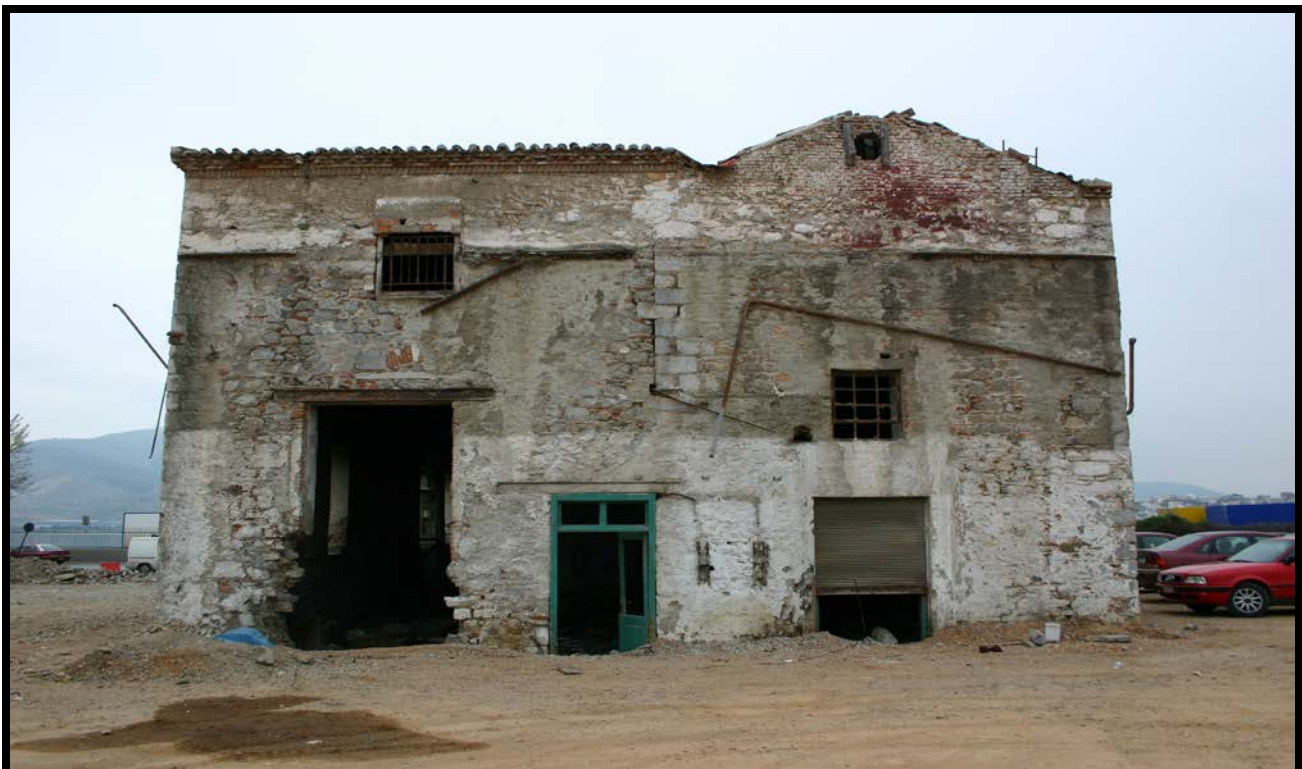
Εικόνα 20 : Υπάρχουσα Ανατολική όψη κτιρίου
