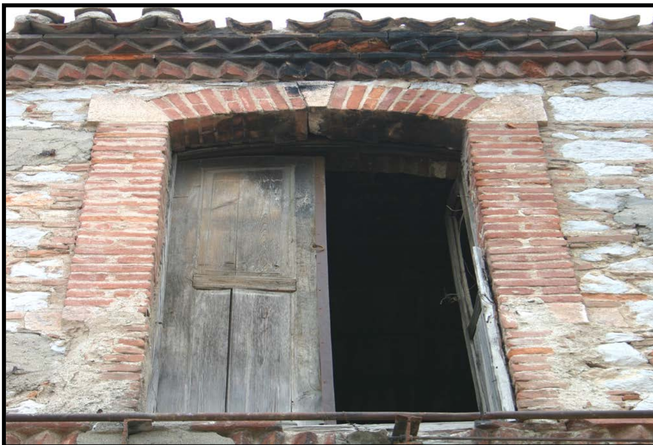
Εικόνα 16 : Κατεστραμμένα κουφώματα
