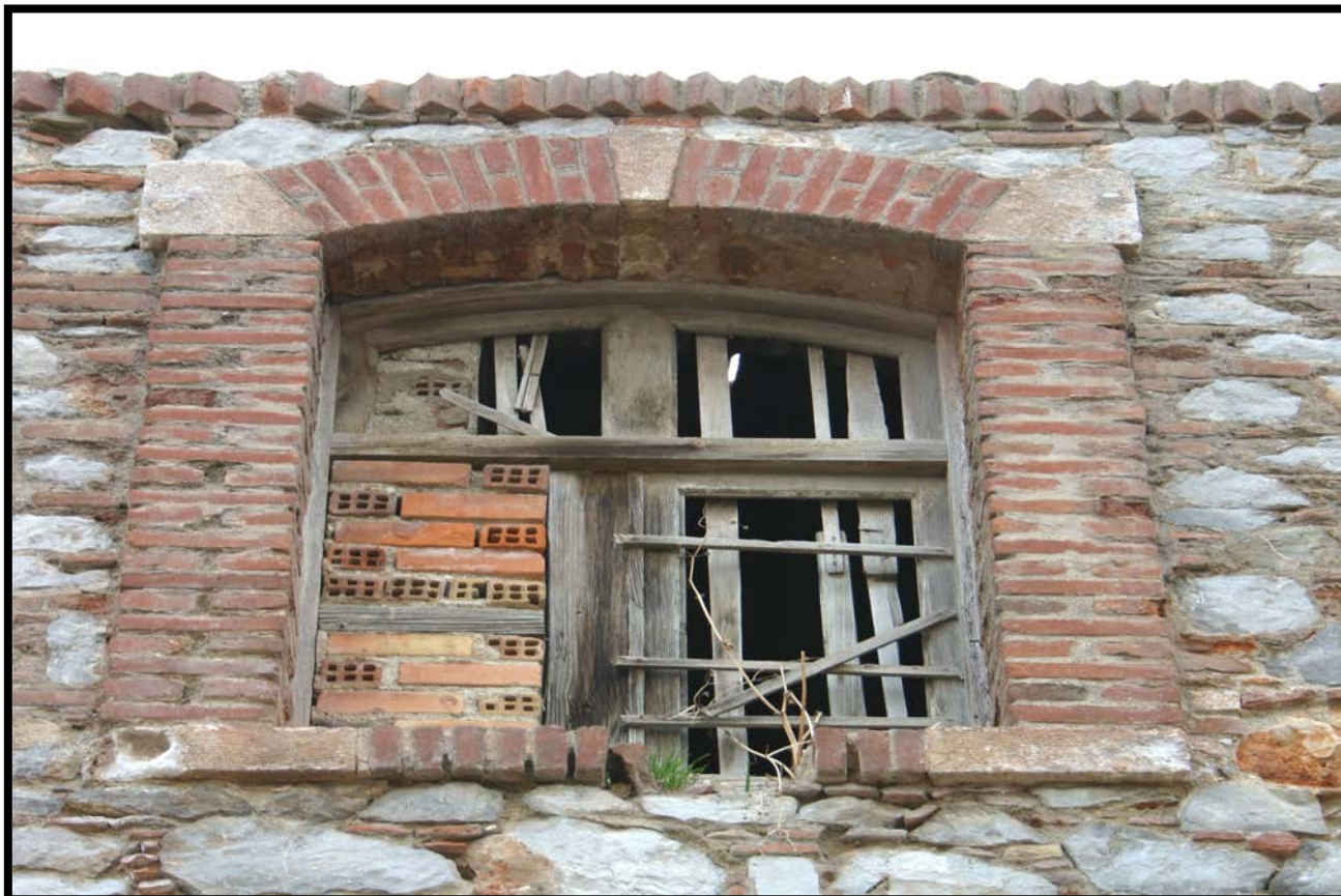
Εικόνα 15 : Κατεστραμμένα κουφώματα
