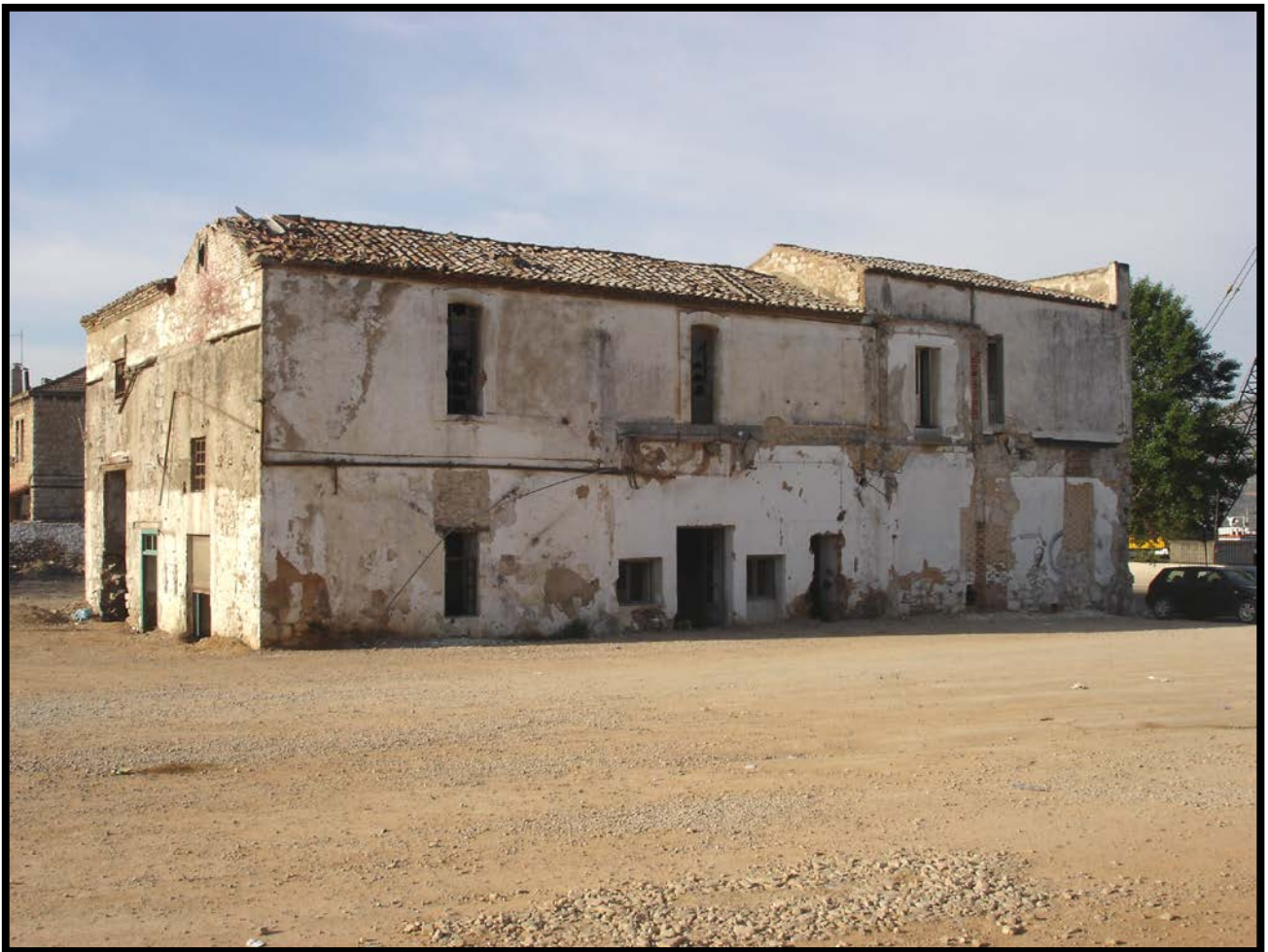
Εικόνα 9 : Σημερινή κατάσταση κτιρίου Α.Σ.Α.Χ. – βόρεια όψη κτίσματος
