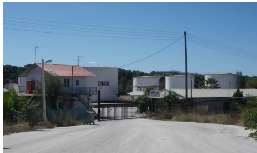
Εικόνα 10 Στην φωτογραφία διακρίνονται το κτίριο διοικήσεως στα αριστερά και τα silos στο βάθος του οικοπέδου
