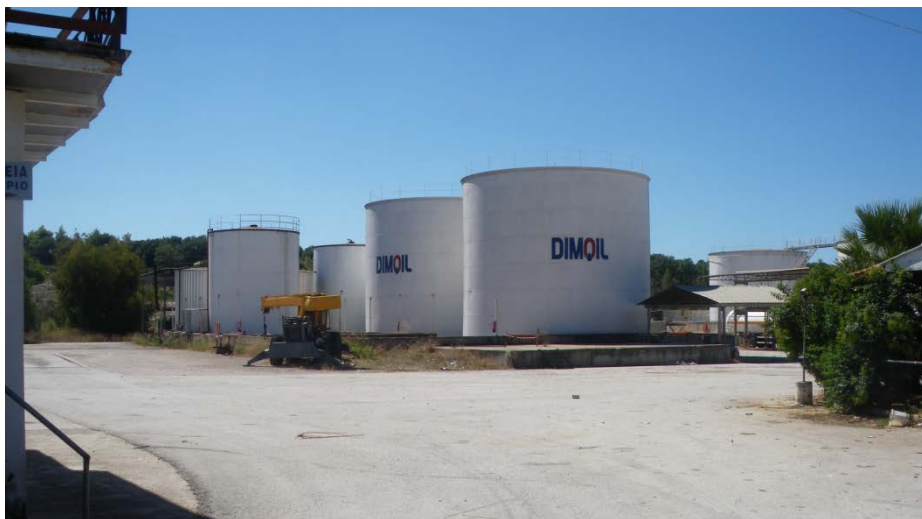
Εικόνα 9 Οι δεξαμενές πετρελαίου. Οι συγκριμένες δεξαμενές βρίσκονται εκτός λειτουργίας και θα πρέπει να αξιοποιηθούν κατά την πρόταση της μελέτης
