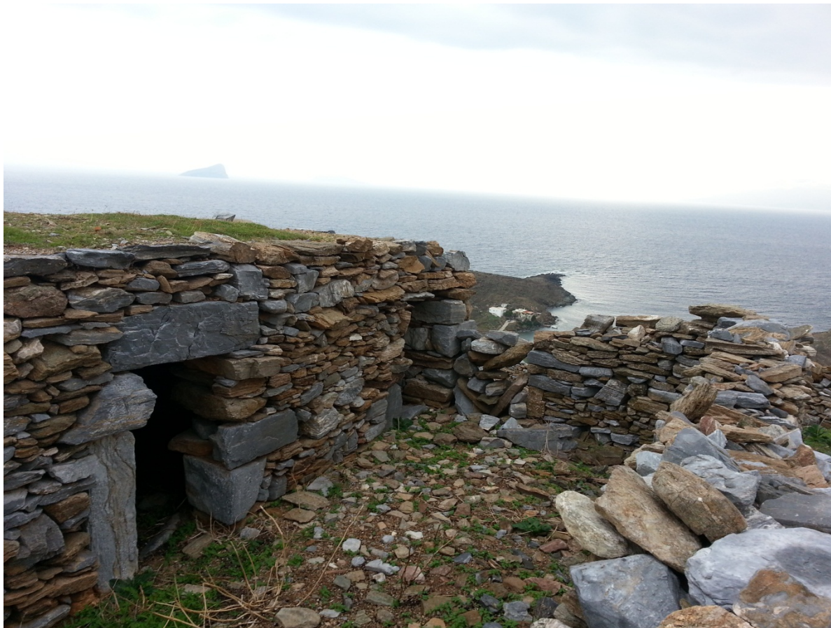
Εικόνα 20. Το κελί που βρίσκεται στη βόρεια όψη της βίγλας. Στις εισόδους του κελιού είναι φανερή η χρήση λίθων από τον πύργο.
