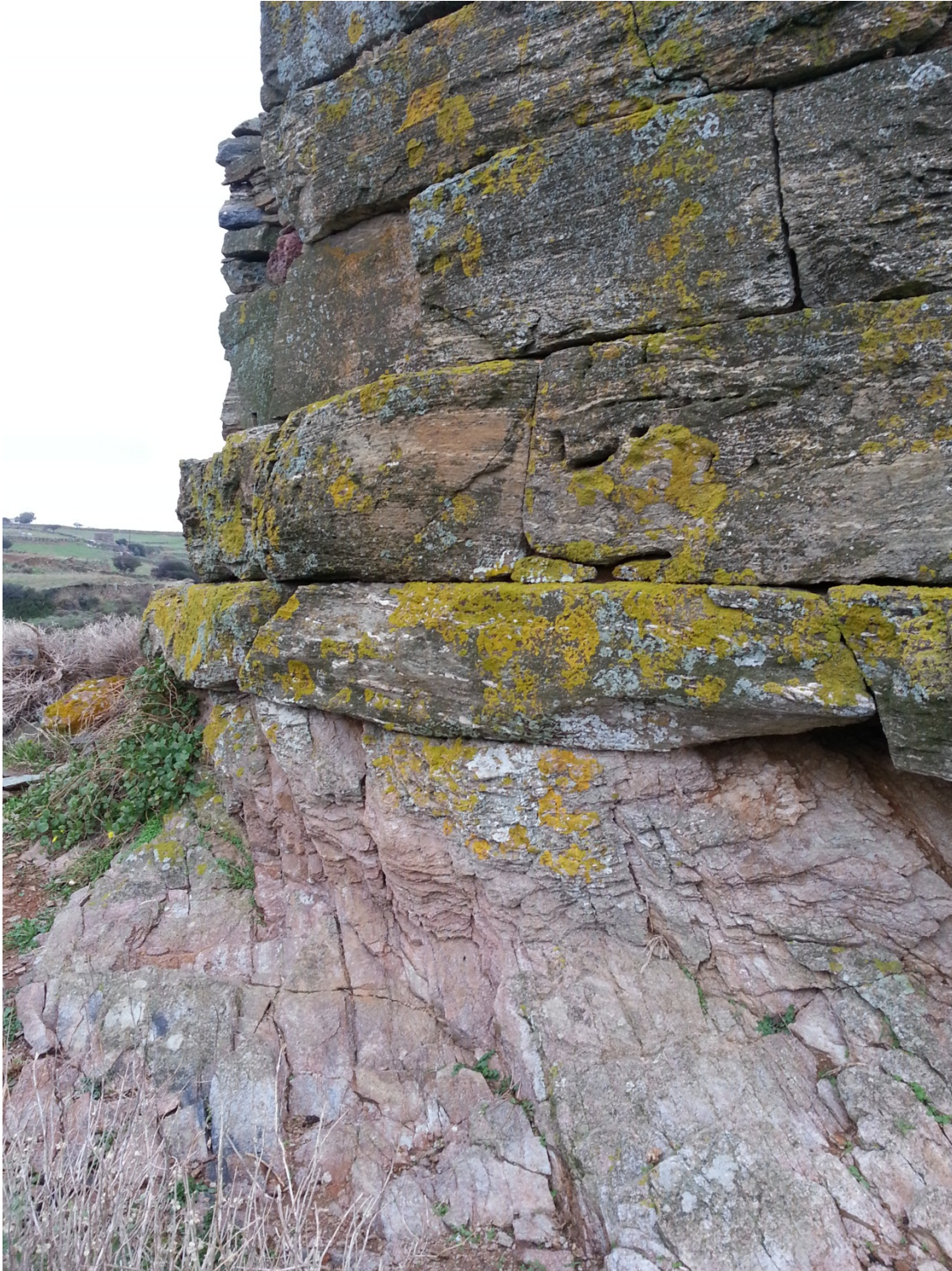
Εικόνα 9. Λεπτομέρεια έδραση πύργου σε υφιστάμενο βράχο.
