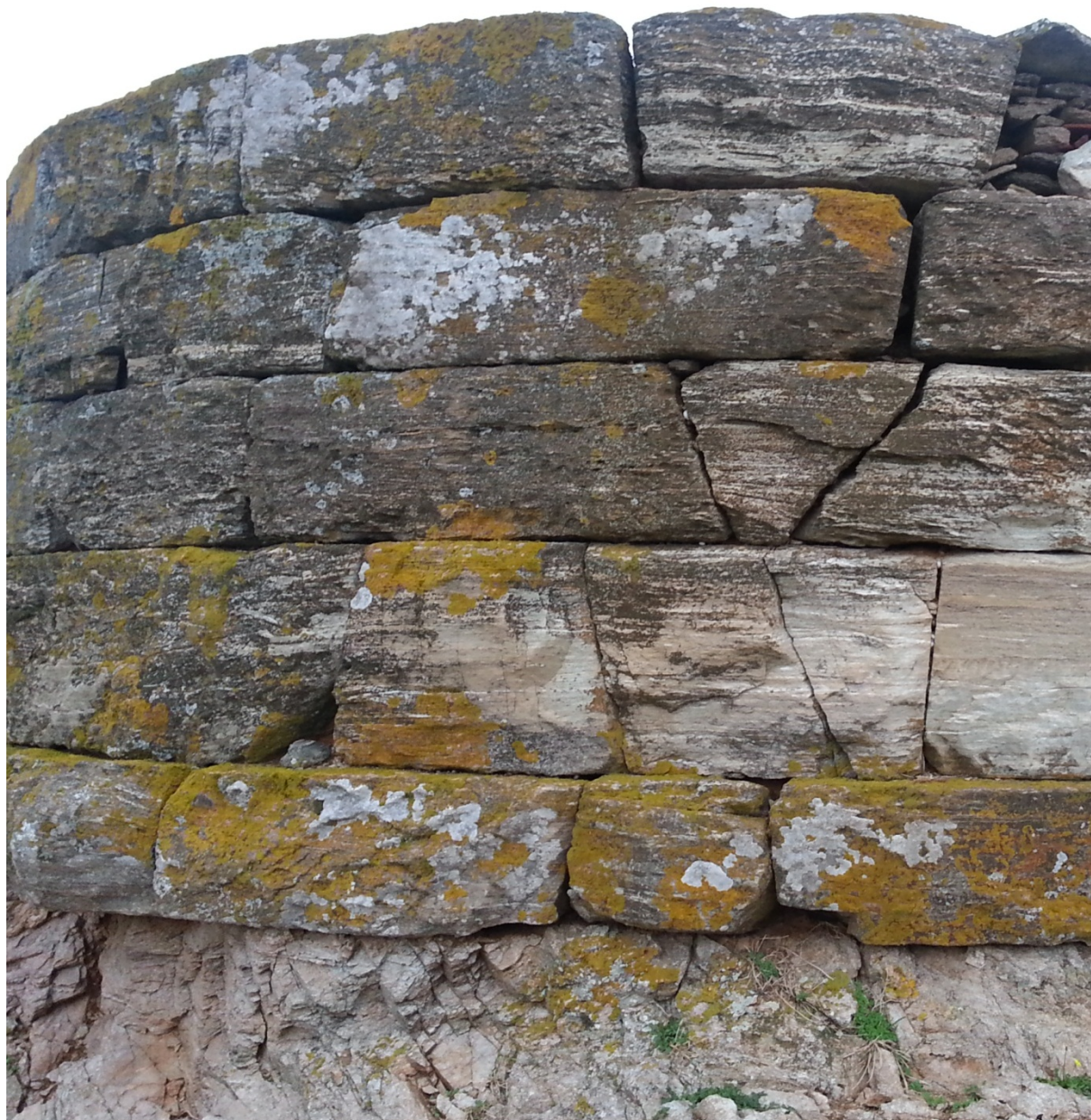
Εικόνα 13. Λεπτομέρεια τοιχοδομής και έδρασης πύργου.
