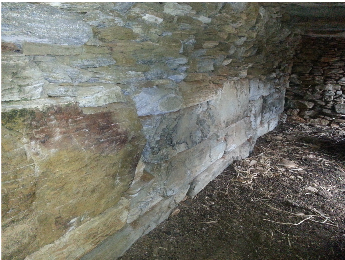
Εικόνα 21. Τοιχοδομή του πύργου στο εσωτερικό του κελιού.
