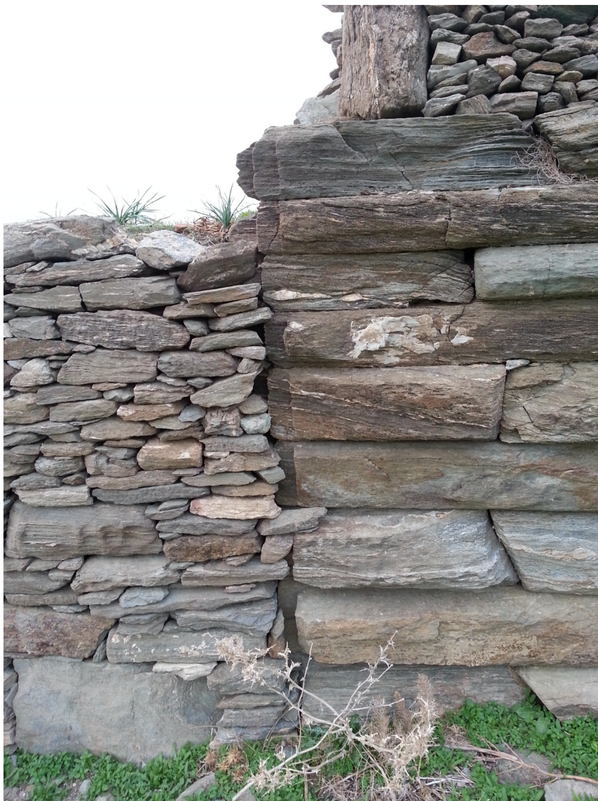
Εικόνα 41. Λεπτομέρεια της τοιχοδομίας και της ένταξης του νεότερου κελιού στον πύργο Δ.
