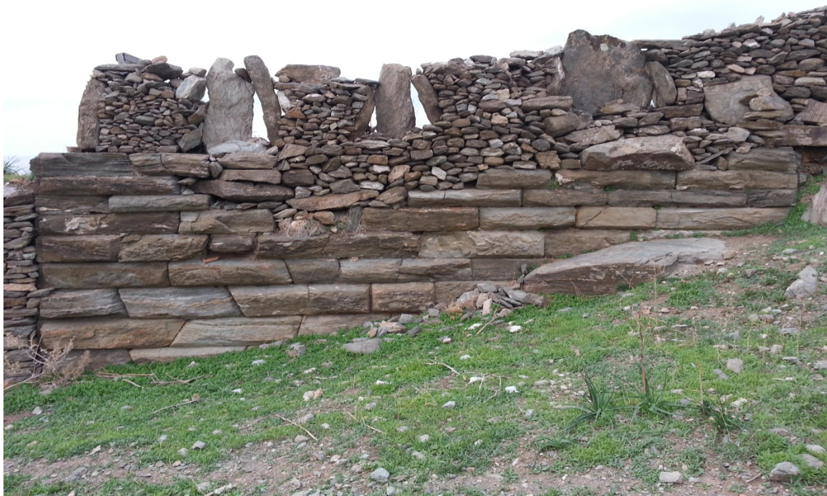
Εικόνα 38. Η νότια όψη του πύργου Δ.
