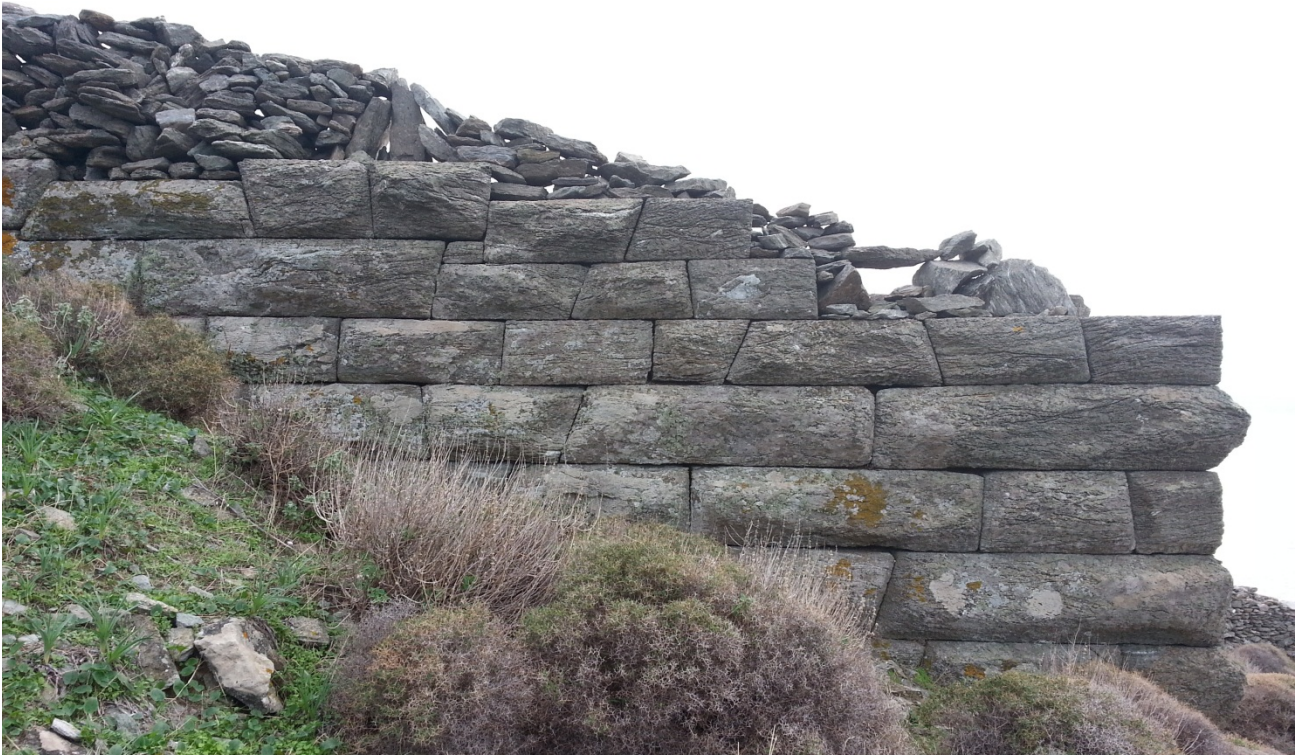
Εικόνα 29. Βορειοανατολική όψη του πύργου ΚΖ.
