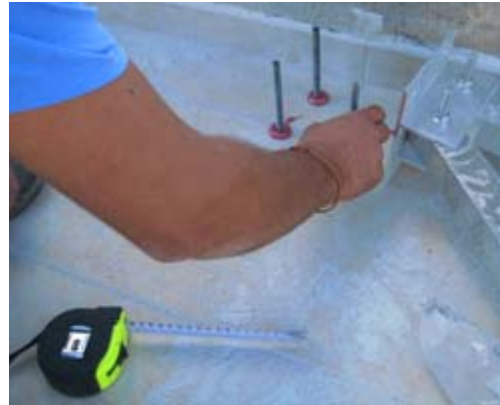
Εικόνα 20 – Εισαγωγή ρητίνης και τοποθέτηση ντιζών
