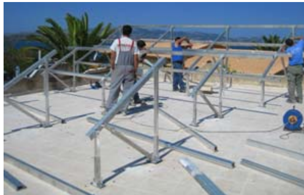
Εικόνα 21 – Τοποθέτηση βάσεων και οριζόντιων προφίλ αλουμινίου
