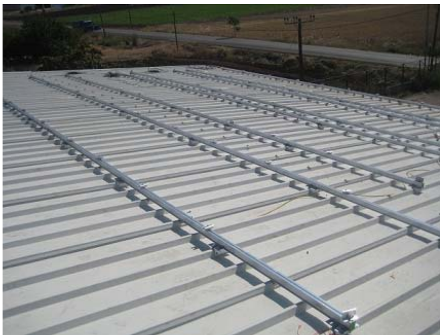
Εικόνα 18 – Μηκίδες αλουμινίου πάνω σε βιομηχανική- βιοτεχνική στέγη
