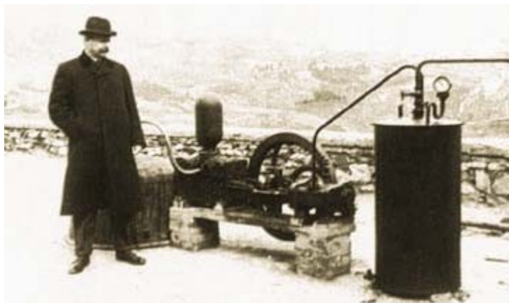
Εικόνα 11 - Σύστημα παραγωγής ηλεκτρικής ενέργειας από γεωθερμικό ατμό
