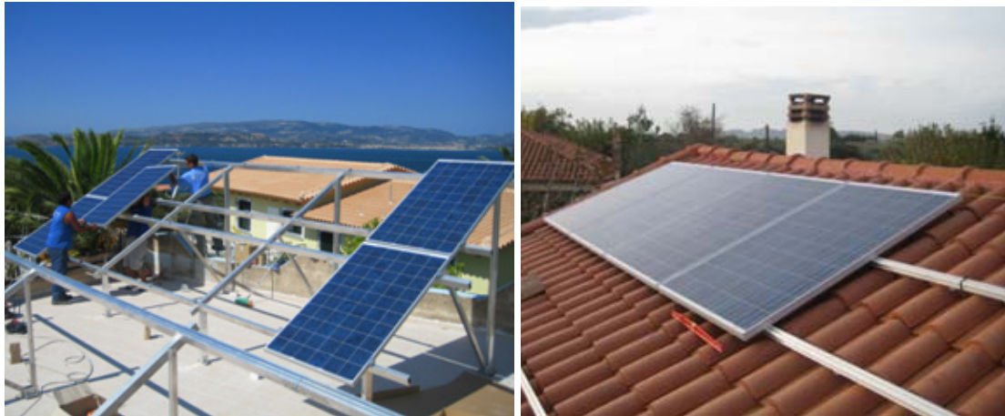
Εικόνα 22 – Τοποθέτηση φωτοβολταϊκών (α) σε ταράτσα και (β) σε στέγη
