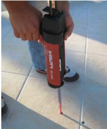
Εικόνα 20 – Εισαγωγή ρητίνης και τοποθέτηση ντιζών
