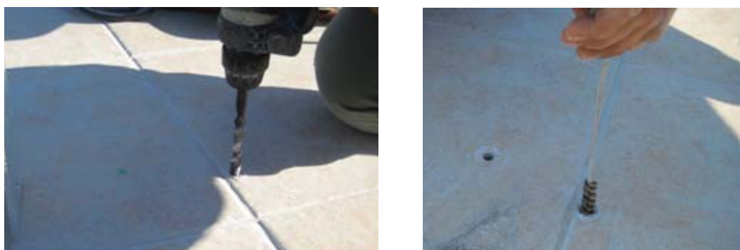
Εικόνα 19 – Άνοιγμα και καθαρισμός οπών
