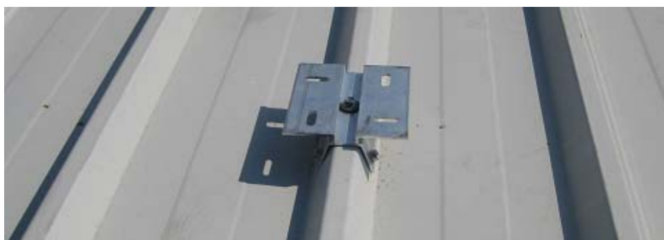
Εικόνα 17 – Αγκύριο σε βιομηχανική – βιοτεχνική στέγη
