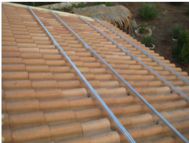
Εικόνα 16 – Τοποθέτηση βάσεων στήριξης σε στέγη
