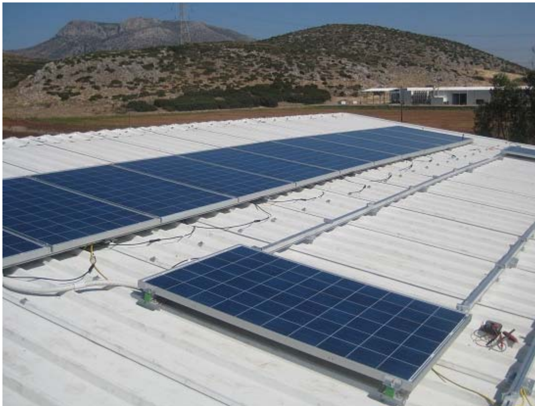
Εικόνα 23 – Τοποθέτηση φωτοβολταϊκών σε βιομηχανική στέγη
