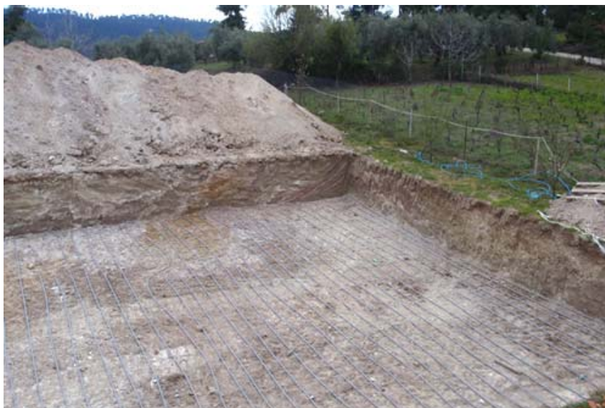
Εικόνα 3 – Φωτογραφία συστήματος με οριζόντιο γεωθερμικό εναλλάκτη
