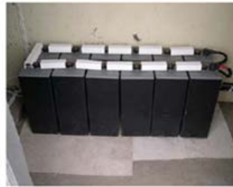
Παραδείγματα συστοιχίας αυτοσωρευτών σε εγκατάσταση Φ/Β
