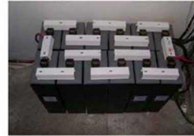
Παραδείγματα συστοιχίας αυτοσωρευτών σε εγκατάσταση Φ/Β
