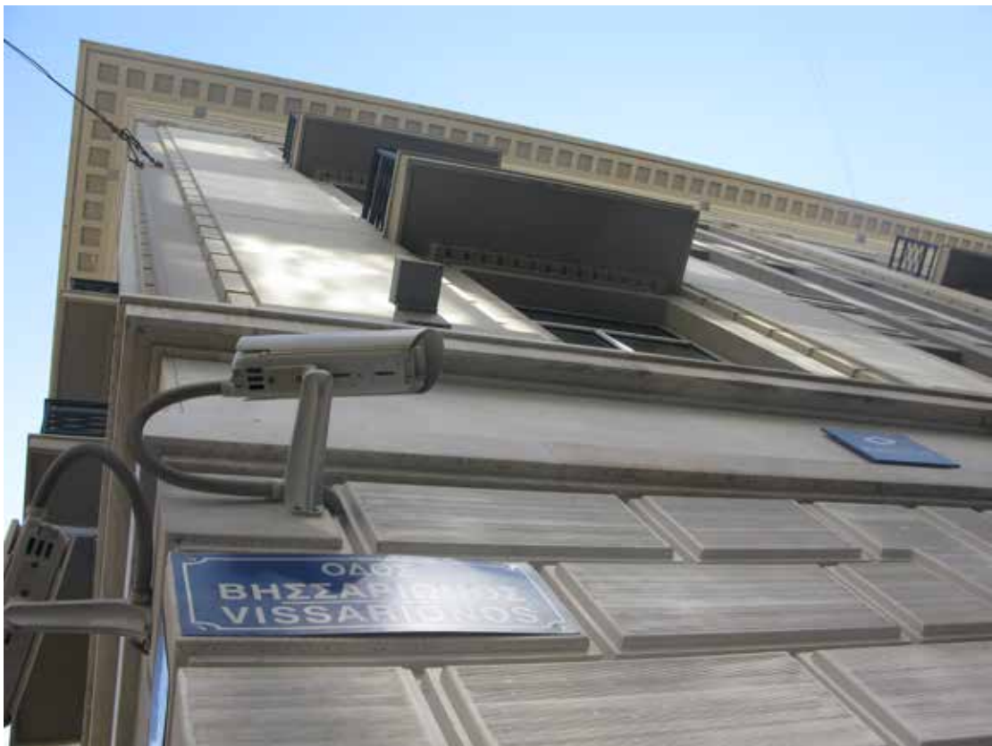
Εικόνα 4.5.2, Φωτογραφίες του δώματος και της όψης από την οδό Βησσαρίωνος.
