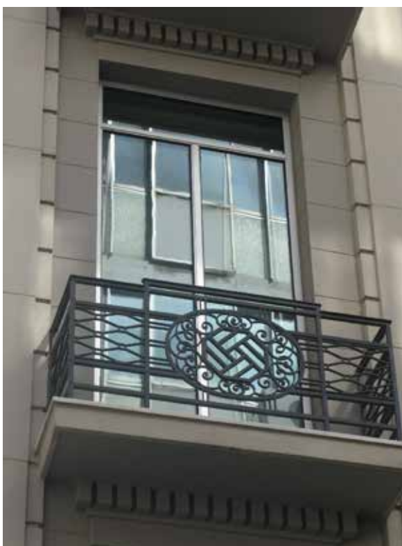
Εικόνα 2.1.1, Λεπτομέρεια κιγκλιδώματος όπως διαμορφώθηκε με το πέρας των εργασιών.
