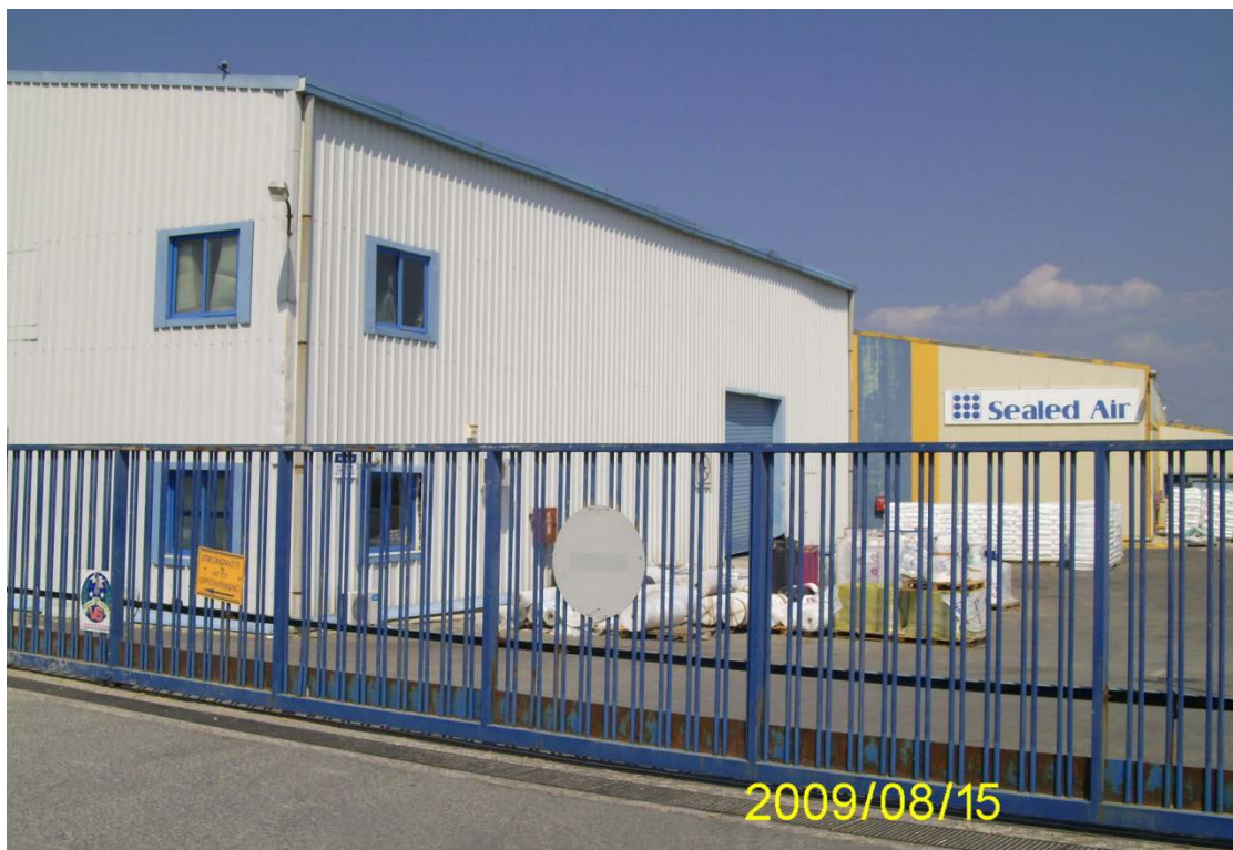
Εικόνα 21 Sealed Air A.B.E.E.
