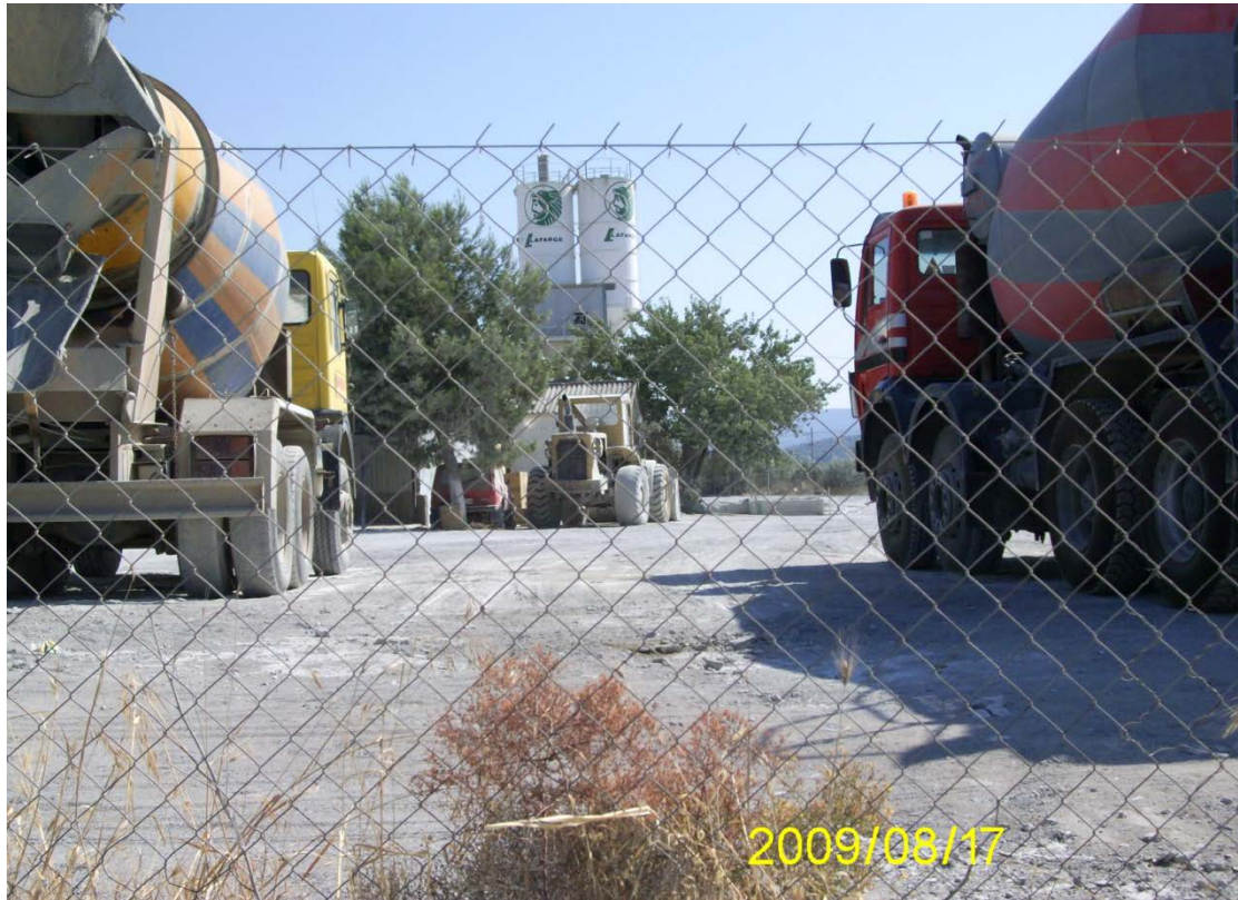
Εικόνα 60 Εργοστάσιο σκυροδέματος LAFARGE
