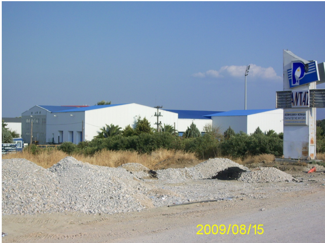
Εικόνα 44 Βιομηχανική μονάδα παραγωγής ψύξης και τυποποίηση, επεξεργασία αλιευμάτων
