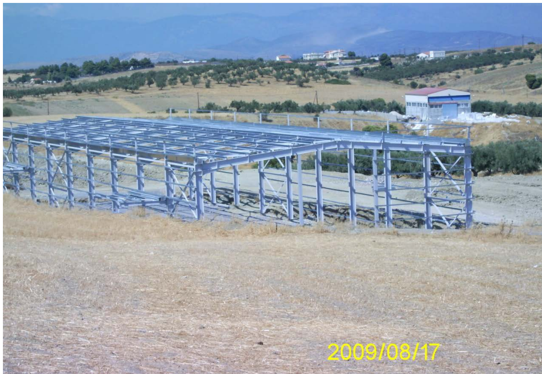
Εικόνα 55 Βιομηχανία υπό κατασκευή
