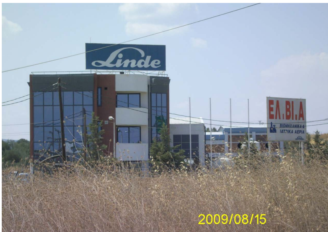
Εικόνα 7 Βιομηχανικά και Ιατρικά Αέρια ΕΛ.ΒΙ.Α
