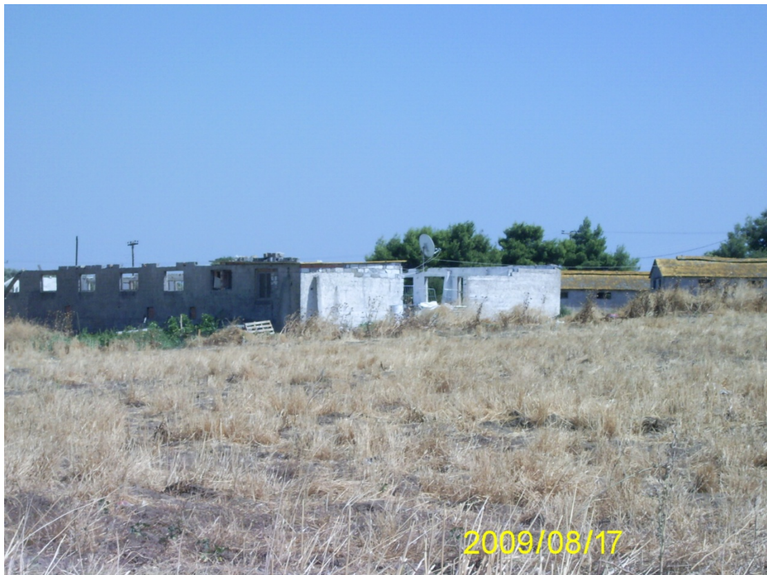
Εικόνα 48 Εγκαταλελειμμένο συγκρότημα κτιρίων
