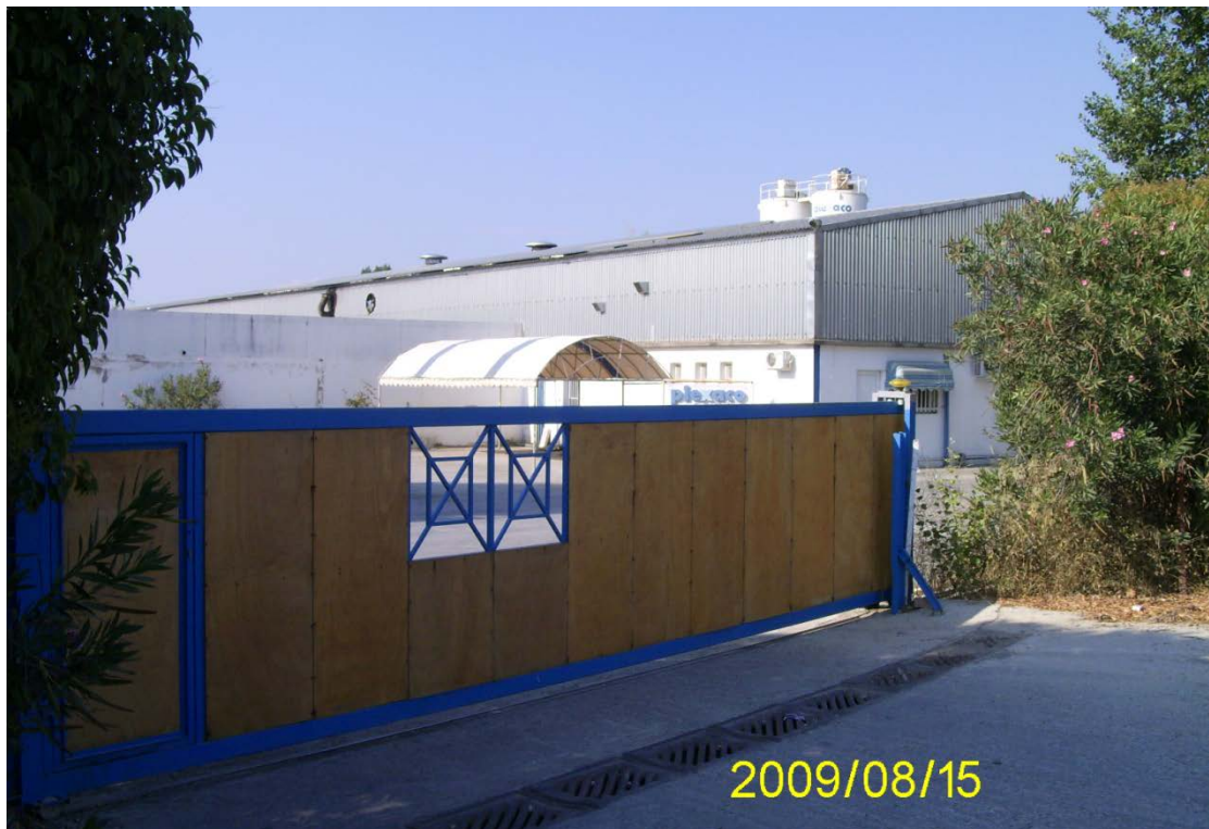
Εικόνα 34 PLEXACO S.A. (Βιομηχανία πλαστικών σωλήνων)
