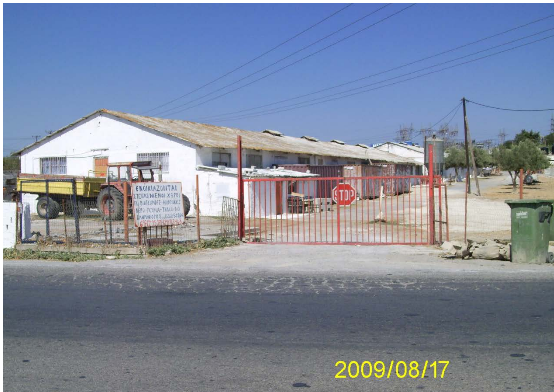
Εικόνα 115 Εγκαταλελειμμένη πτηνοτροφική μονάδα
