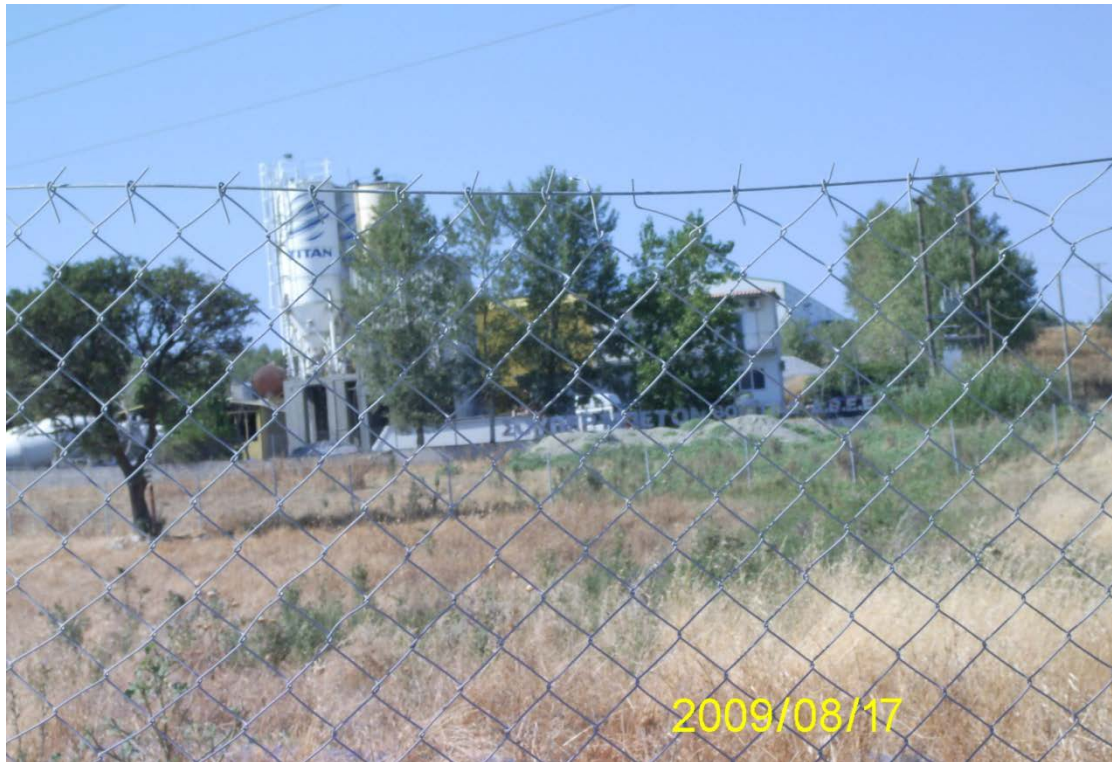
Εικόνα 66 Εργοστάσιο σκυροδέματος ΤΙΤΑΝ
