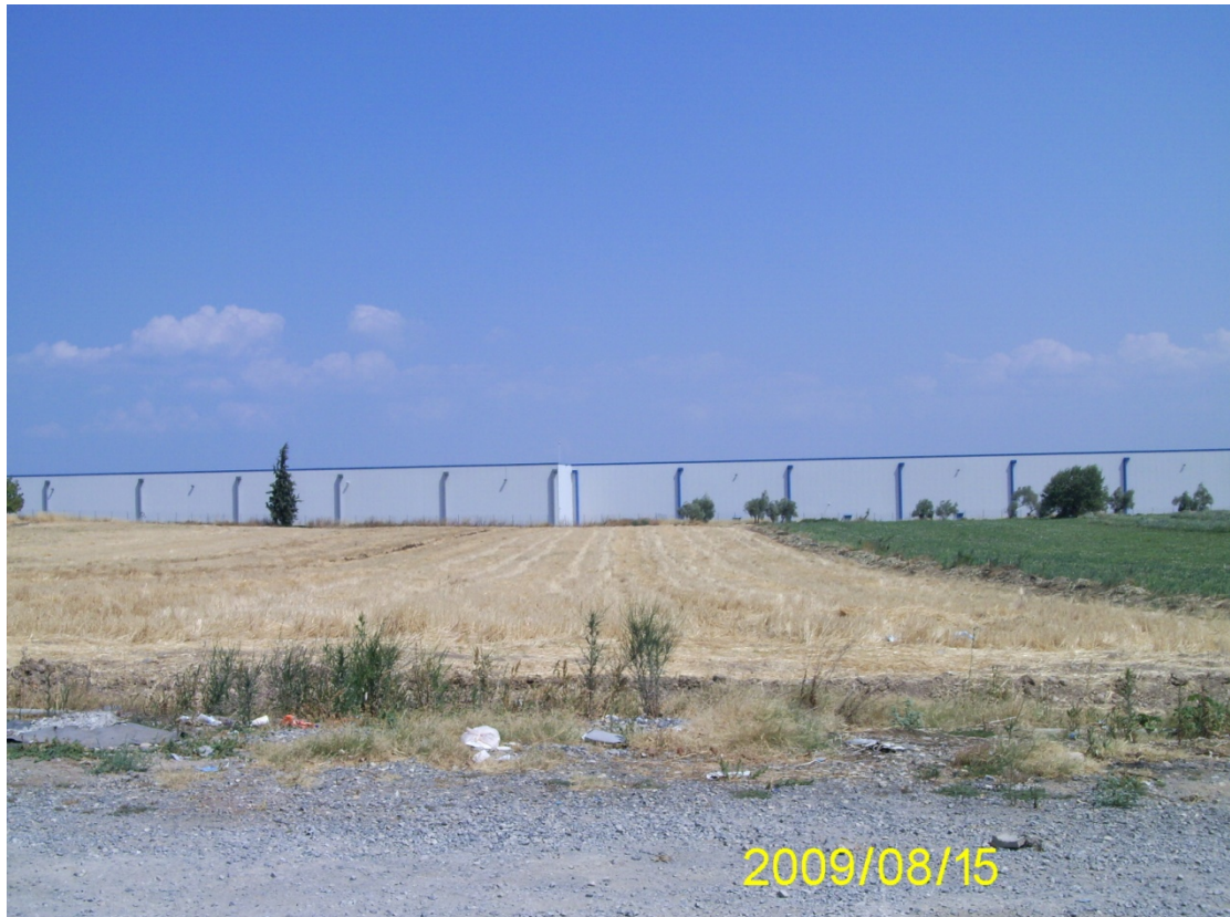
Εικόνα 97 ΕΣΙΑΡ Αποθήκες logistics
