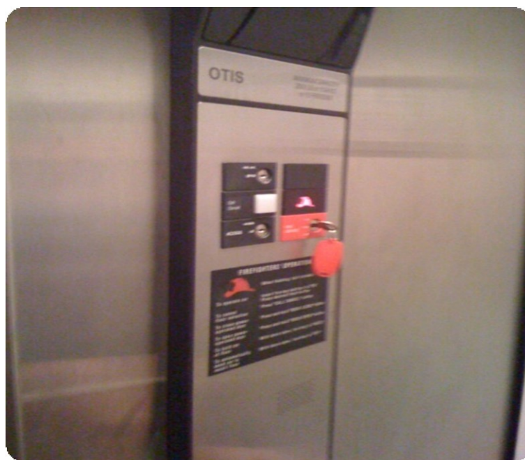
Εικόνα 6-3:Μπουτονιέρα με κλειδί για προαιρετική τοποθέτηση του ανελκυστήρα σε κατάσταση ημιαυτόματης λειτουργίας
