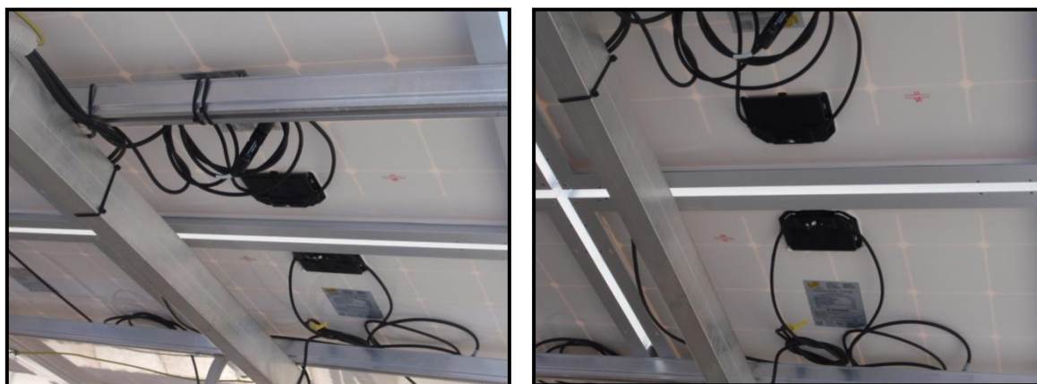
Σχ. 5.3.1.7 Καλωδιώσεις Φωτοβολταϊκών Πάνελ
