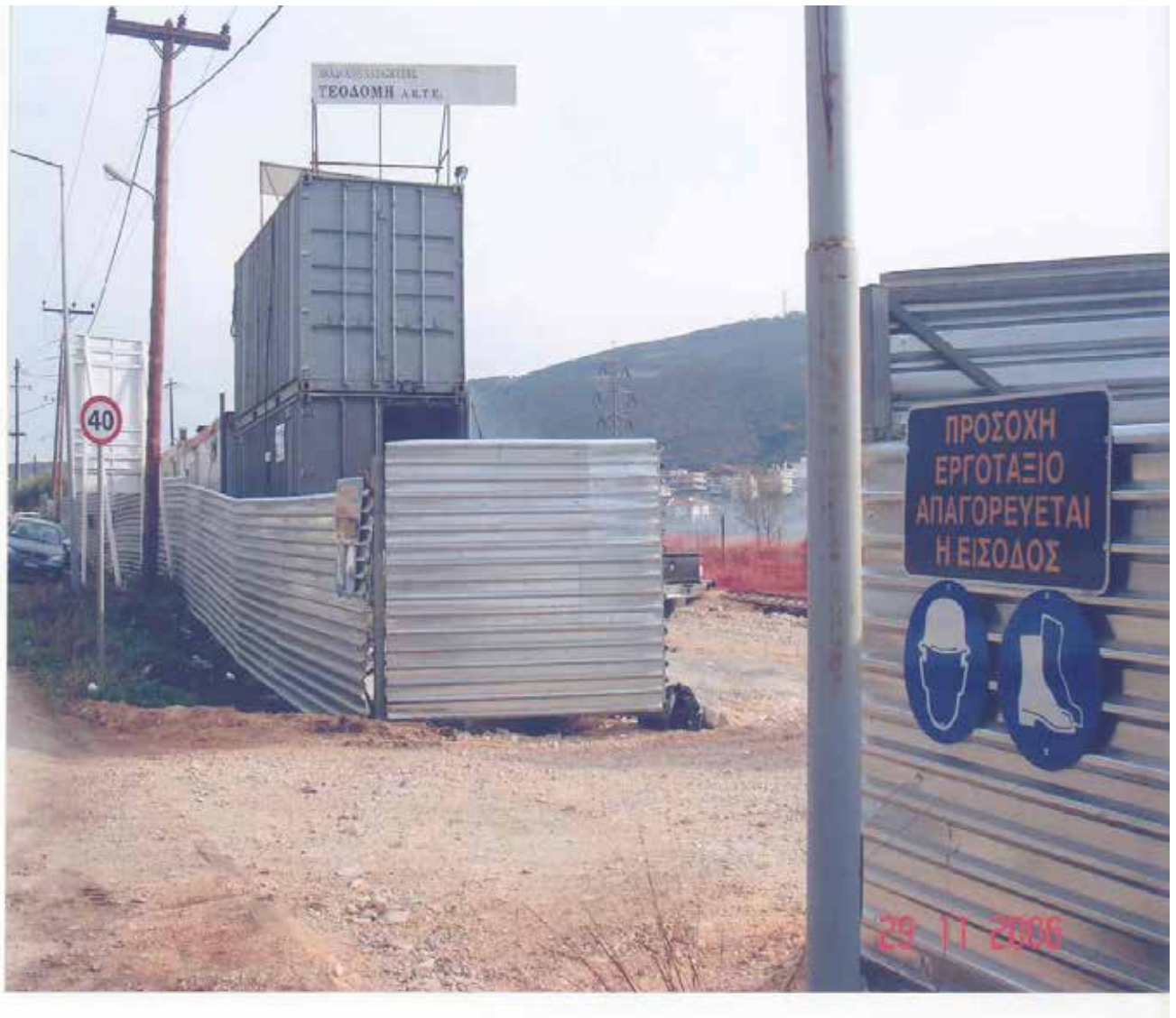
Εικόνα 11 : Η είσοδος του εργοταξίου, η οποία έκλεινε μετά την λήξη των εργασιών, με αναρτημένες τις πινακίδες απαγόρευσης εισόδου στους μη έχοντες εργασία, καθώς και της υποχρεωτικής προστασίας του κεφαλιού και των ποδιών.
