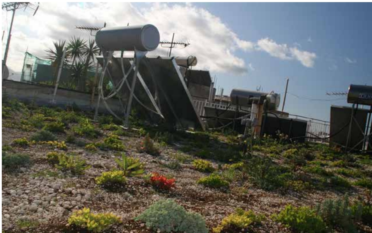
Τελικό στάδιο φυτεμένου δώματος
