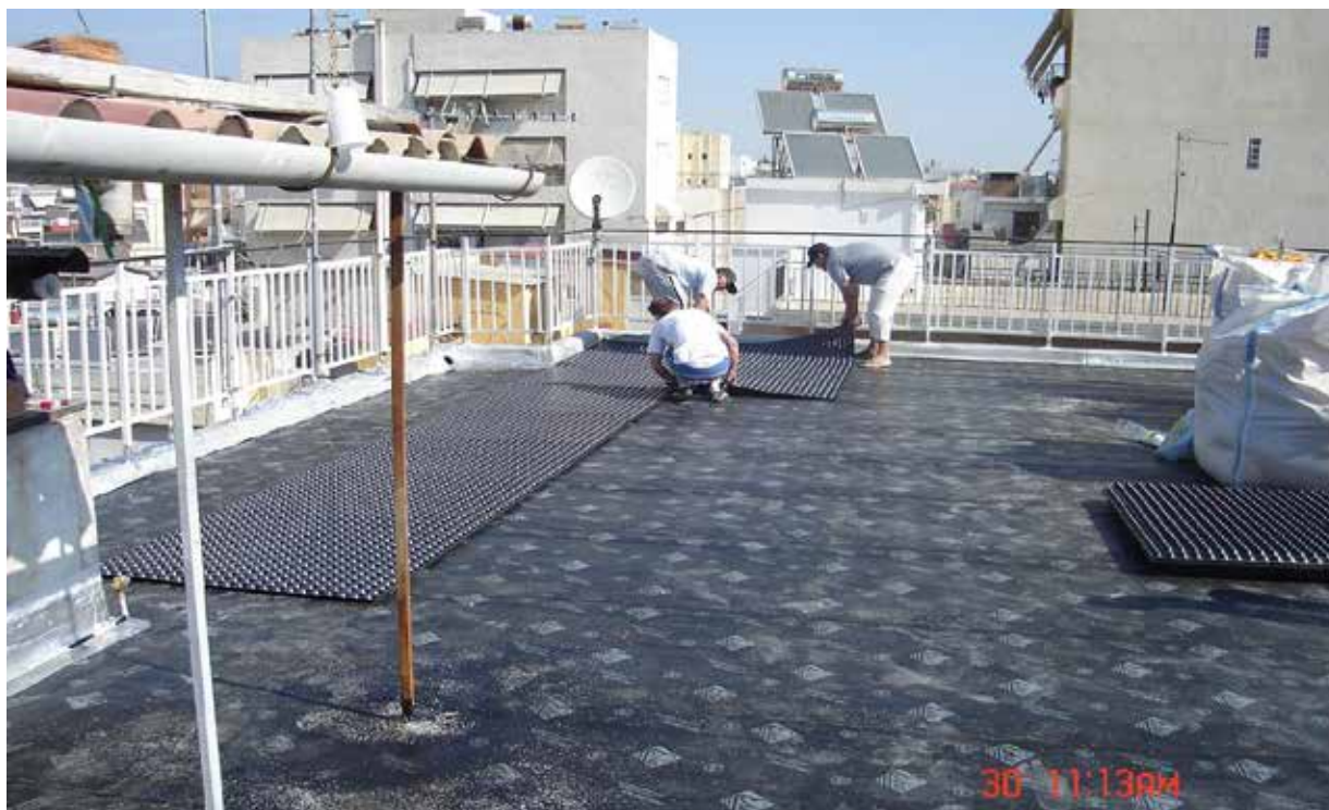
Δώμα με τελική επίστρωση από πλάκες
