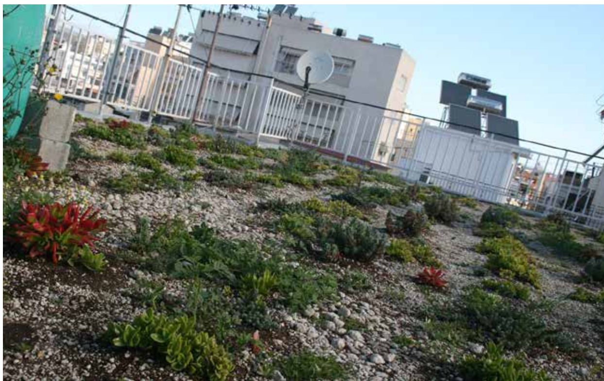
Τελικό στάδιο φυτεμένου δώματος
