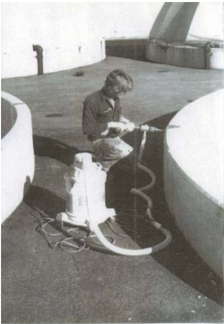
Εικόνα: Αντλία αυξημένης πίεσης, με δοχείο ανάμειξης και μανόμετρο. [ www.epoxysystems.com ]
