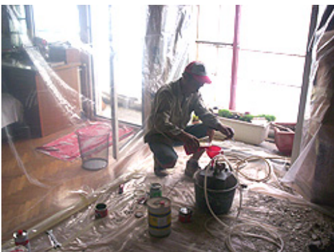
(2) Σε επιλεγμένες θέσεις τοποθετούνται ακροφύσια (ανοιχτοι πόροι) μέσω των οποίων γίνεται η ρητινένεση.
