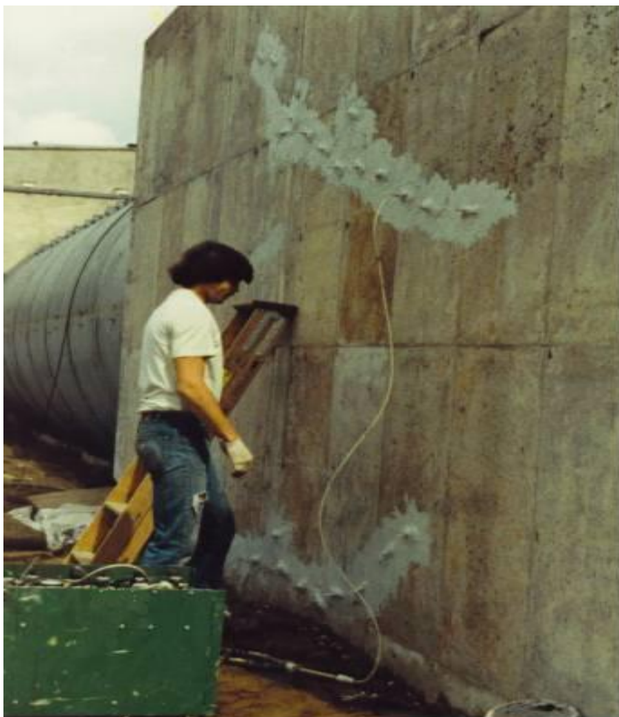
Εικόνα: Εφαρμογή ρητινέυσης για την ενίσχυση και αποκατάσταση των ρωγμών. [ www.epoxysystems.com ]
