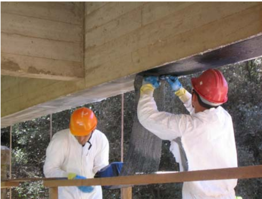
Εικόνες: Εφαρμογή ανθρακούφασμάτων σε δομικά έργα [ www.truesdellcorp.com ]
