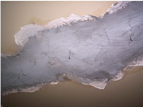
(1) Σφραγίζεται η ρωγμή με εποξειδική πάστα σε όλο το ανάπτυγμά της
