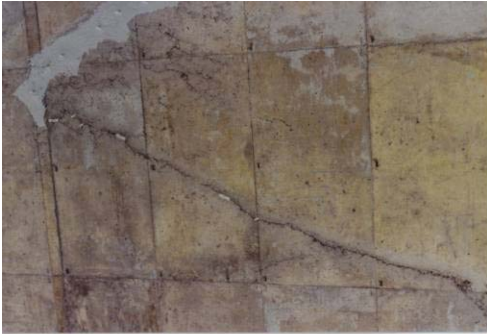
Εικόνα: Προσπάθεια επισκευής και ενίσχυσης ρηγματωμένης πλάκας. www.epoxysystems.com
