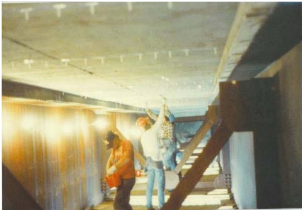
Εικόνα: Προσπάθεια επισκευής και ενίσχυσης ρηγματωμένης πλάκας. www.epoxysystems.com
