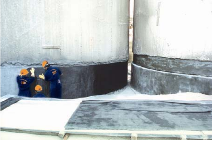
Εικόνες: Εφαρμογή ανθρακούφασμάτων σε δομικά έργα [ www.truesdellcorp.com ]
